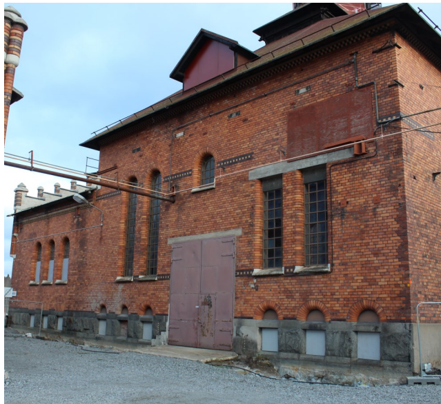
Bild 55: Förändringar i fasaderna syns tydligt i form, på västra fasaden i form av en ny port samt igensättning av håltagning för produktionsteknisk utrustning.
