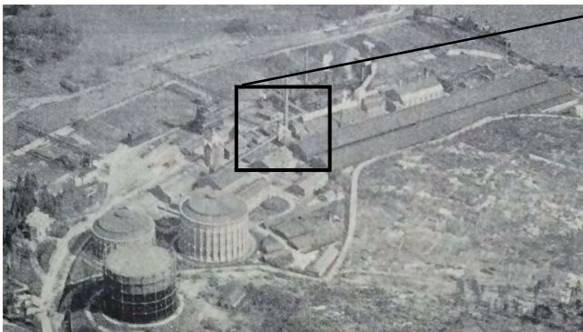
Bild 18: Foto från 1926 där ursprungligt utförande fortfarande är intakt. Notera även gasverksledningen som går rakt in i byggnadens sydvästra fasad. Källa: Gasverksföreningens Årsbok
