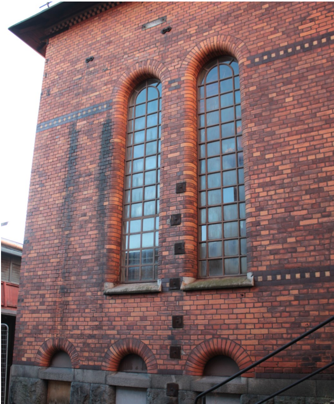
Bild 53: Höga fönster i originalutförande på östra fasaden med bröstmurning i både över- och underkant
