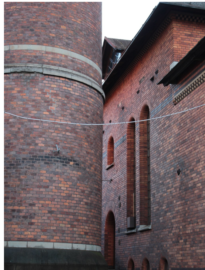
Bild 65: Byggnaden möter den intelligande skorstenen samt detalj av sågtandning vi takfot
