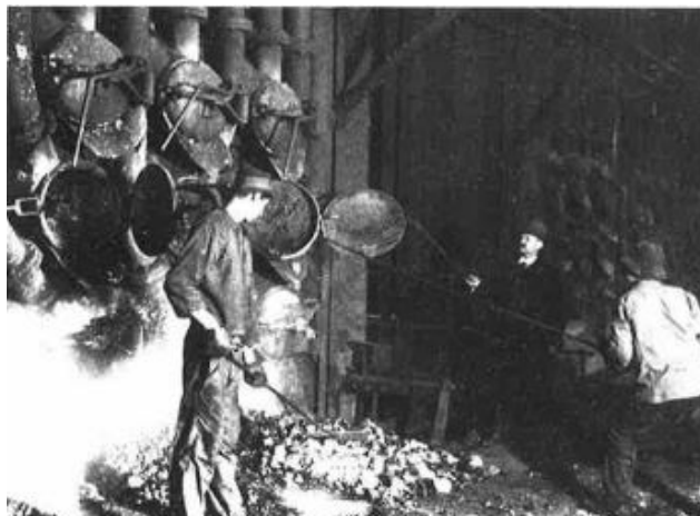
Bild 12: Utrakning av glödande koks ur retorterna vid 1900-talets början. Källa: Ljus, kraft värme
