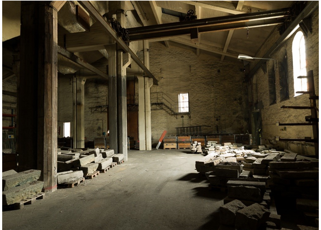
Bild 25: Foto av västra delen av hus 24 med väggen som avdelar mot hus 25 i bakgrunden, år 2015. Nivån för plattformen kan ses vid den kvarvarande balken mellan pelarna under koksäckarna till vänster i bild.
