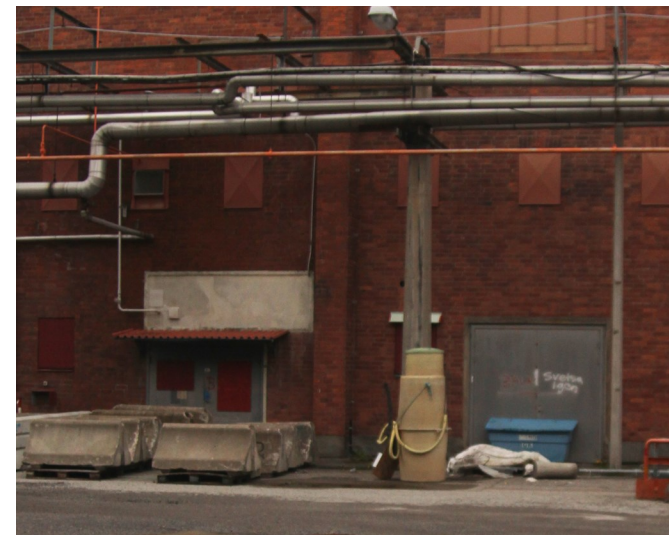
Bild 24: Foto av fasad mot söder visande utbytt dörrparti till häger i bild. Till vänster i bild ses en bytt förr och förstorat fönster. Jämför med bild 23.
