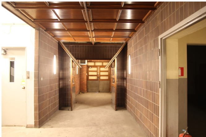
Bild 29: Foto från bottenvåningen visande ursprungliga ytskikt på väggar och kasetttak i trä. Ursprunglig dörr i bakgrunden.
