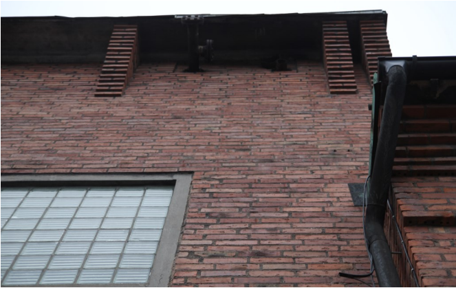
Bild 86: Den mycket nätta takfoten med sågtandsmurning under.
