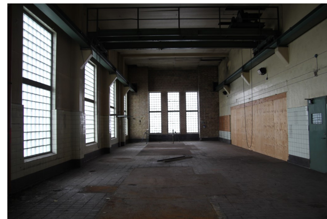
Bild 31: Foto av gamla turbinhallen, idag oanvänd. Notera de ursprungliga ytskikten på väggarna med bröstning av vitt kakel och mörk golvklinker.
