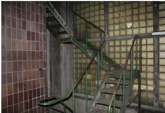
Bild 93: Gjutjärnstrappa i ångpannerummet.
