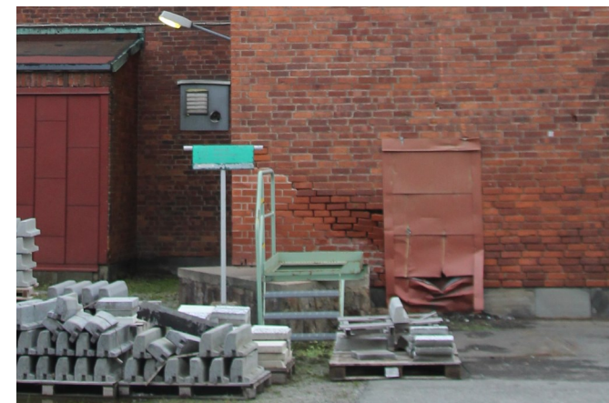
Bild 26: Foto visande den lastbrygga som revs under 2014. Se även tidigare påkörningsskada i fasaden.
