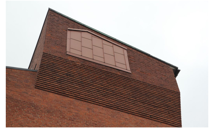
Bild 87: Sågtandad murning även under den utskjutande högdelen.
