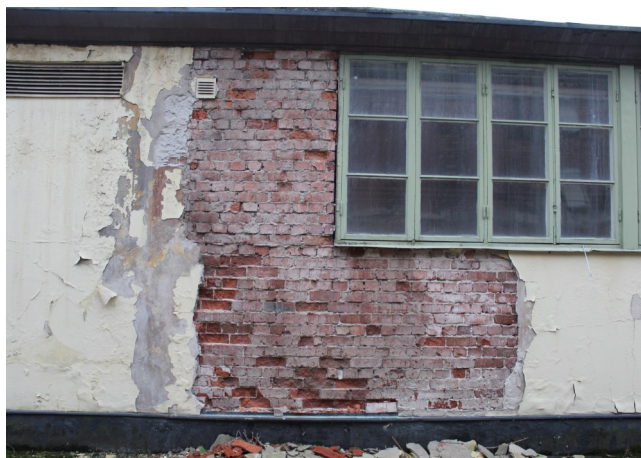
Bild 76: Vittrad fasad med plastfärg som släpper från fasaden. Bilden är tagen 2014.
