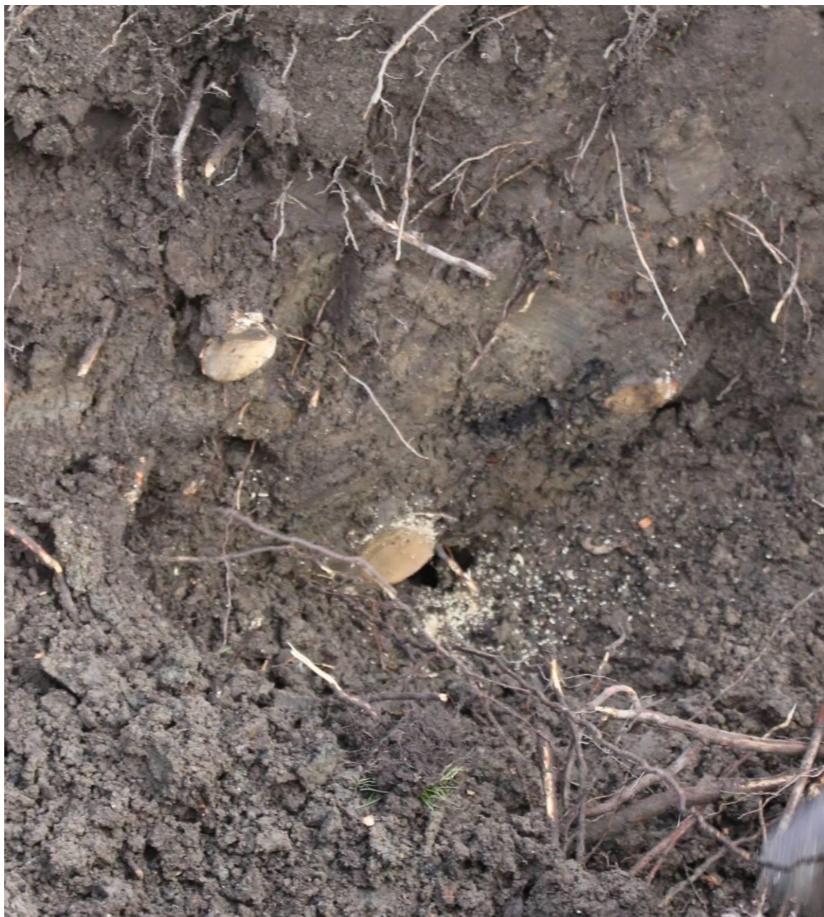
Bild 4. Korrekt beskurna rötter vid schakt.
