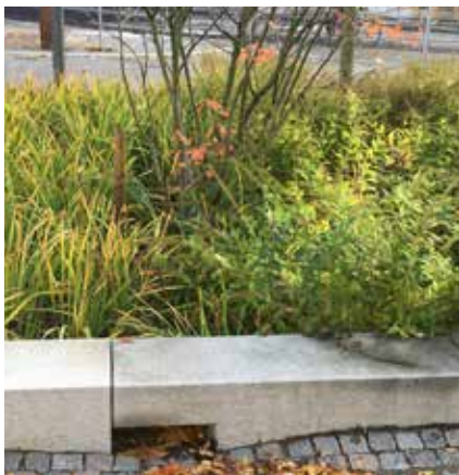
Regnbädd för dagvattenhantering.
