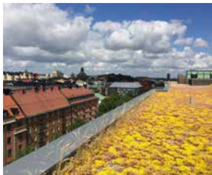
Underbyggd vegetationsklädd yta på tak. Växtbäddsdjup 20-70 mm.
