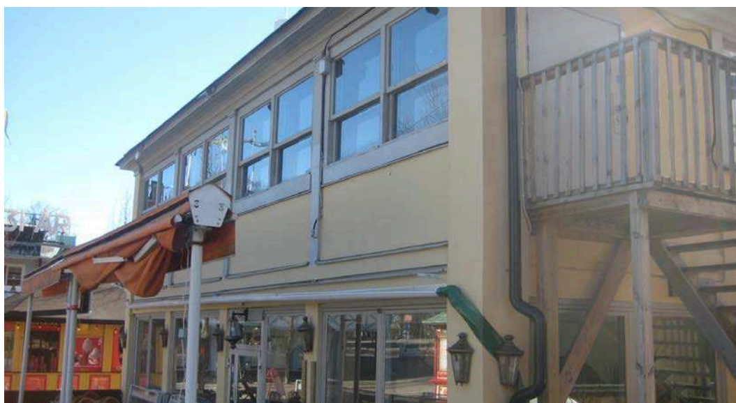
Tillbyggnadens fasad mot öster. Sentida skivinklädnad i underkant av övervåningens fönster. Till höger utvändig utrymningstrappa av provisorisk karaktär.
