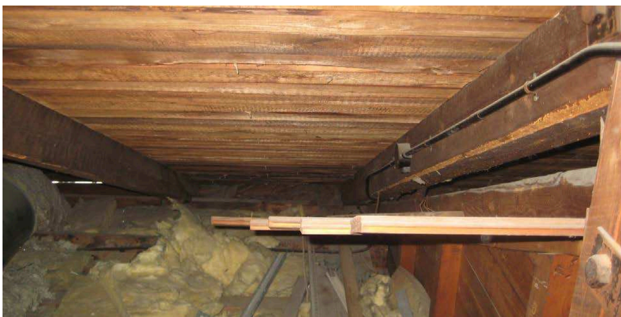
Exempel på takkonstruktion och yttertakspanel i tak över den tillbyggda delen. Kvarsittande barkrester förekommer som kan dölja mindre skadedjursangrepp.
