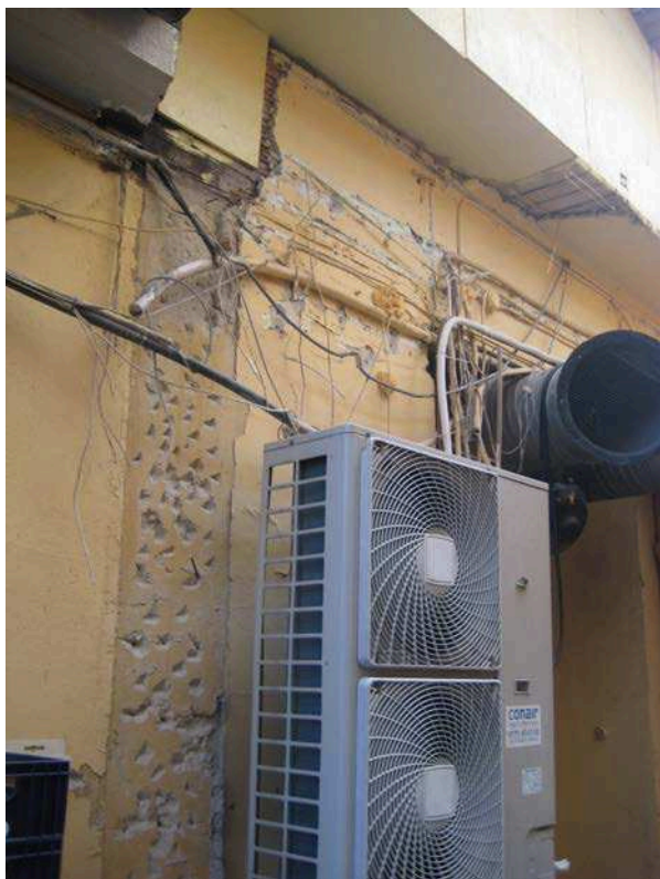
Utvändiga installationer i gränden mot norr. Delvis provisoriskt monterade och bristfälligt avslutade efter tidigare rivningsåtgärder.
