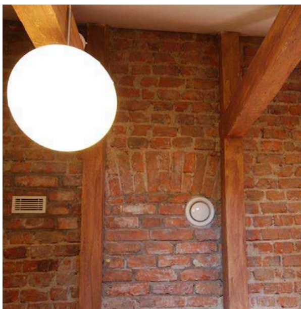
Frilagd tegelmur på våning 1 tr. med spår av ursprunglig, igenmurad öppning mot norr.
