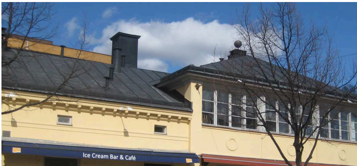
Fasad mot söder. Takyterna på hela byggnaden är belagda med svartmålad slät stålplåt i skivformat. Takavvattnings via ståndrännor och utvändiga stuprör med utkastare vid mark.
