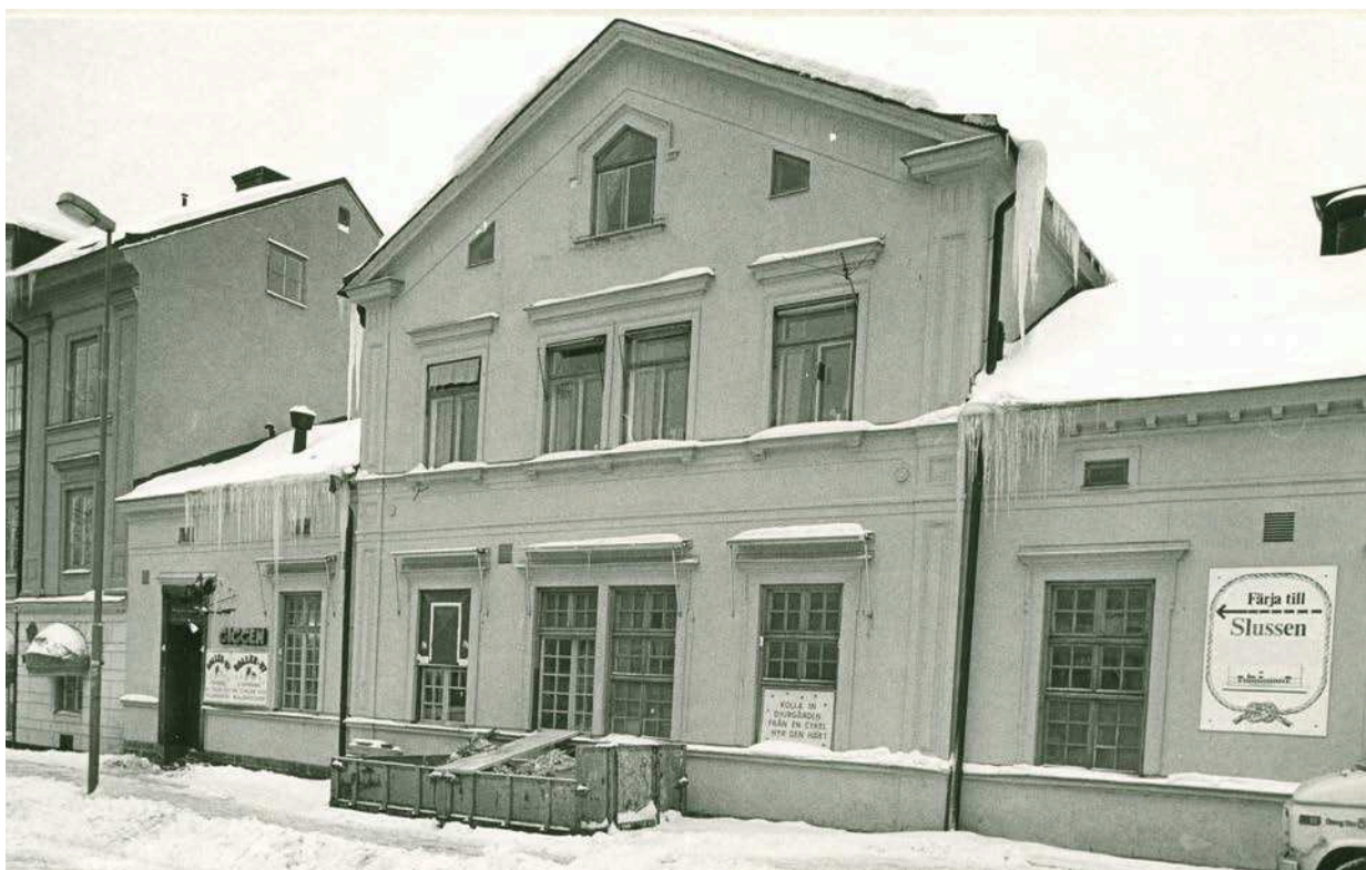
Fotografiet visar byggnadens fasad mot Allmänna gränd 1982. Byggnaden har äldre spröjsade fönsterbågar utan insticksarm. Några av fönstren är emellertid ändrade sedan fotografiet ovan togs. Stockholms stadsmuseum.
