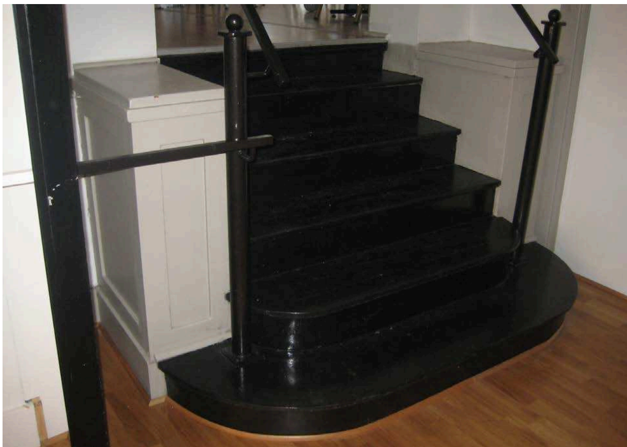
Invändig trappförbindelse i tillbyggnadsdelen som gör att restauranglokalerna på övervåningen inte är tillgängliga för rörelsehindrade.
