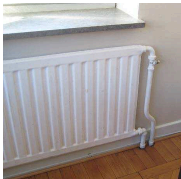
Äldre vattenradiator i tillbyggnadsdelen. Stora rördimensioner som är anpassade för självtryckssystem.
