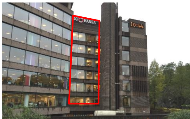
Exempel på inre hörn mot norr där påbyggnaden skulle kunna kraga ut i begränsad omfattning, dvs inte utanför omgivande byggnadsdelar. Till höger i bild syns också befintliga ventilationsgaller integrerade i tegelfasaden. Foto: White arkitekter
