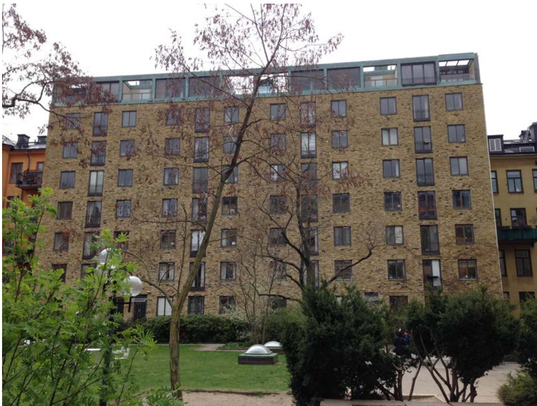
Gårdsfasaden Nebulosan 32 i livfullt gult tegel med öppen takvåning med ett halvtransparent fasaduttryck med delvis inglasade rum, samt pisk och vädringsbalkonger mellan kopparplåtklädda pelare och takbalkar.
