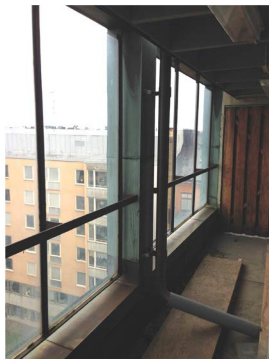
Originaldörr med förskjuten luftad panel till helglasat utrymme (vädrings/piskbalkong) med tak. Glasparter med luftad distans till de kopparbeklädda fasad- och takbalkarna.
