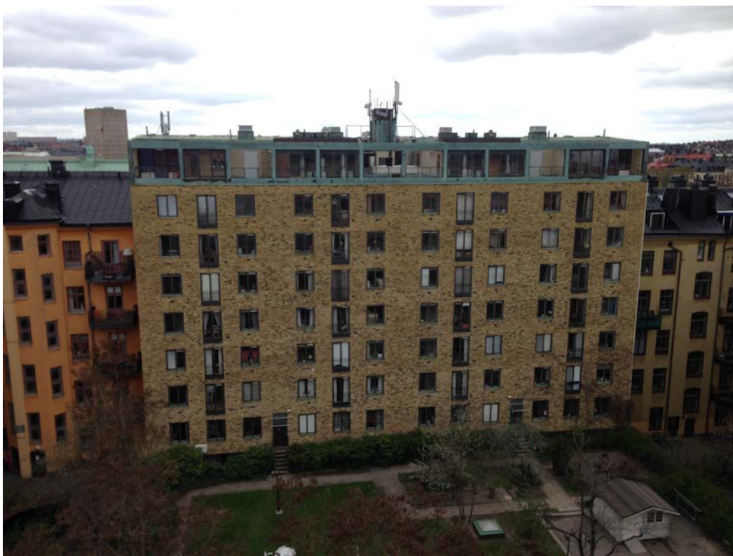
Nebulosan 33, fasad mot gård, foto från terrass på Nebulosan 32. Takvåningen har dels helglasade originalpartier som täcker hela öppningen, och öppna uterum med originalglasräcken. Glasat tak och tätt tak förekommer även, se foton nedan.
