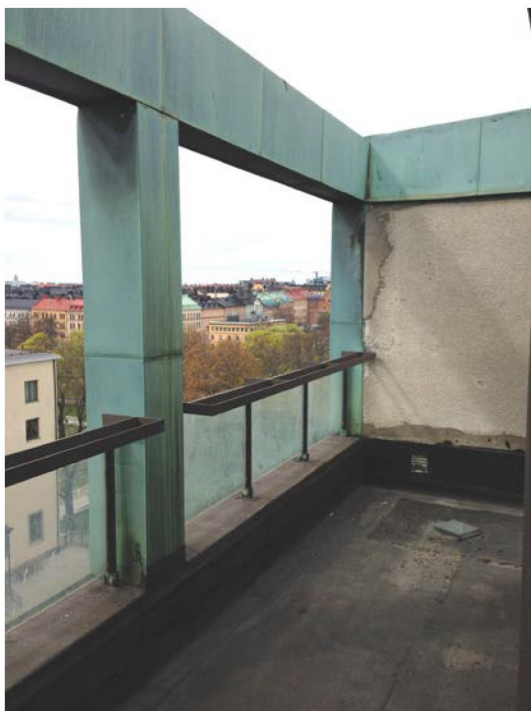
Detalj takvåning Nebulosan 33. Öppna terrasser med glasade originalräcken. Lägg märke till de kopparplåtbeklädda och vackert ärgade fria fasadbalkarna på pelare Puts med genomfärgad ädelputs med glimmerinslag. Vissa skador på puts förekommer.
