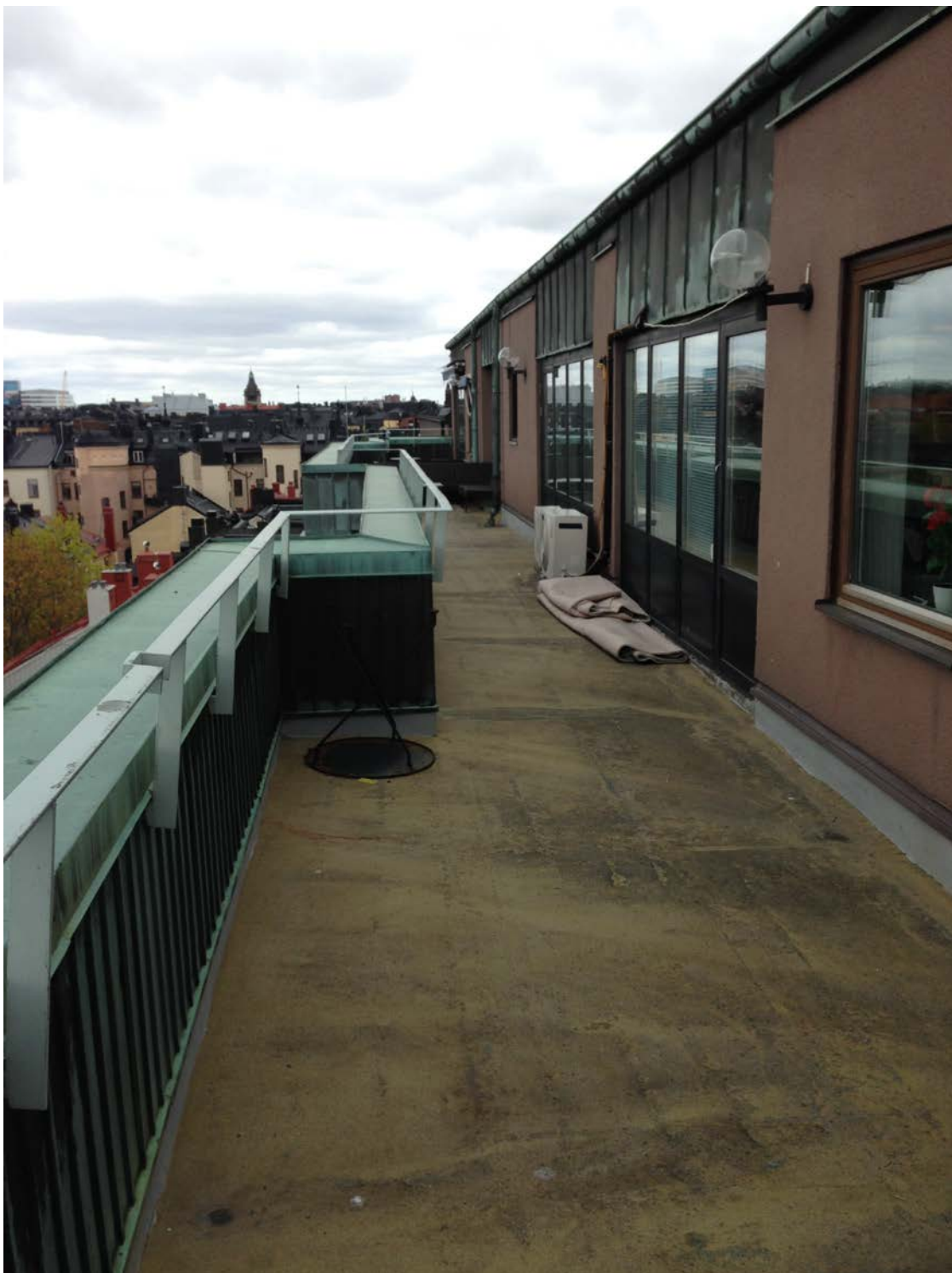
Nebulosan 32 med indragen hel terrass. Den kopparbeklädda fasadmuren har senare kompletterats med ett förhöjt gråmålat räcke. Sentida tätskikt på terrass. Brun puts samt kopparbeklädnad på fasad. Kopparbeklätt tak på båda fastigheterna 32 och 33.
