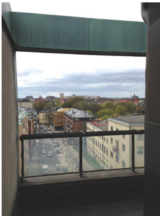
Detalj takvåning Nebulosan 33. Öppna terrasser med glasade originalräcken. Lägg märke till de kopparplåtbeklädda och vackert ärgade fria fasadbalkarna på pelare Puts med genomfärgad ädelputs med glimmerinslag. Vissa skador på puts förekommer.
