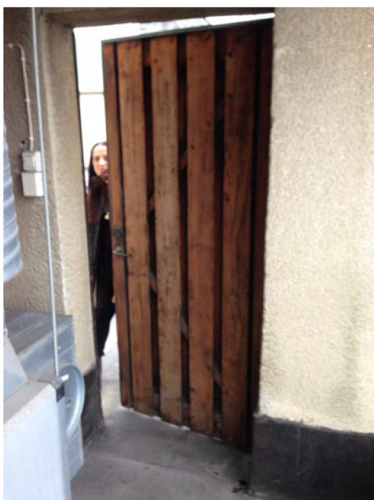
Originaldörr med förskjuten luftad panel till helglasat utrymme (vädrings/piskbalkong) med tak. Glasparter med luftad distans till de kopparbeklädda fasad- och takbalkarna.
