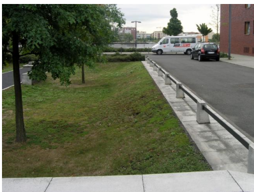
Figur 5 Exempel på låglinjer i gräsytor. Vid regnväder samlas vatten på ytan för att långsamt infiltrera genom bjälklagets överbyggnad. Vid torrväder upplevs ytan som en försänkning i gräsytan.
