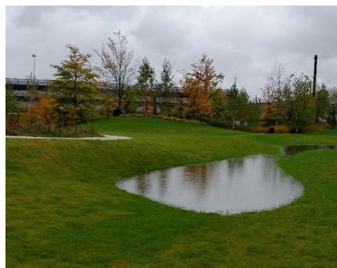
Figur 5 Exempel på låglinjer i gräsytor. Vid regnväder samlas vatten på ytan för att långsamt infiltrera genom bjälklagets överbyggnad. Vid torrväder upplevs ytan som en försänkning i gräsytan.
