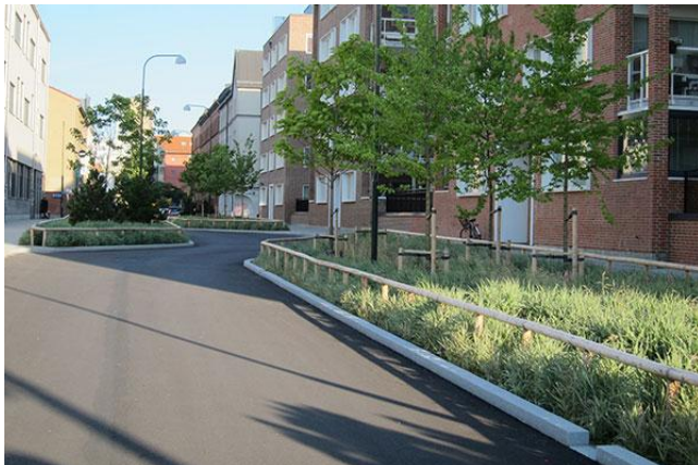
Figur 6 Exempel på nedsänkt växtbädd runt innergården. Med öppningar i kantstenen leds enkelt vatten från omgivande ytor in mot växtbädden.
