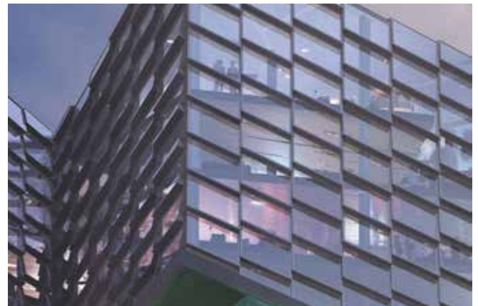
Exempel på glas med strukturverkan. Glaspaneler med mindre livskillnad på Skeppet närmast Fleminggatan och paneler med en kraftigare förskjutning på Muttrarna.
