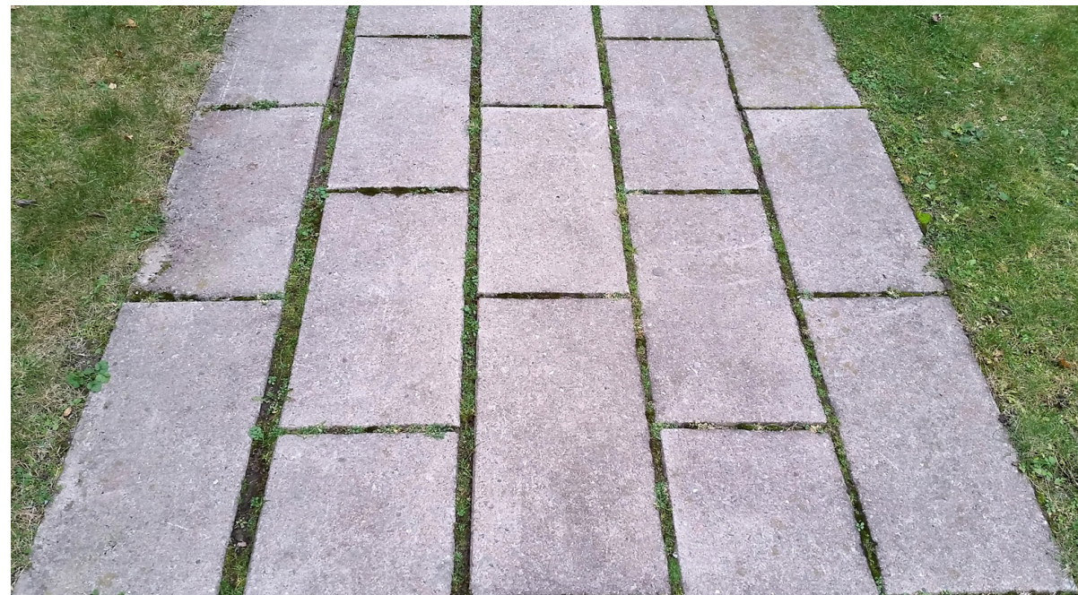
Den ursprungliga markbeläggningen med avlånga betongplattor bevaras enligt förslaget.
