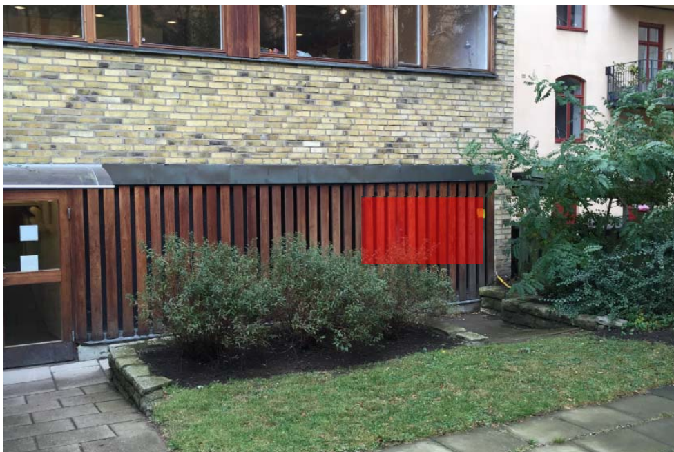
Figur 3. Källa S2 och S3. Öppningar för avluft på fasad Kv Nebulosan 33.
