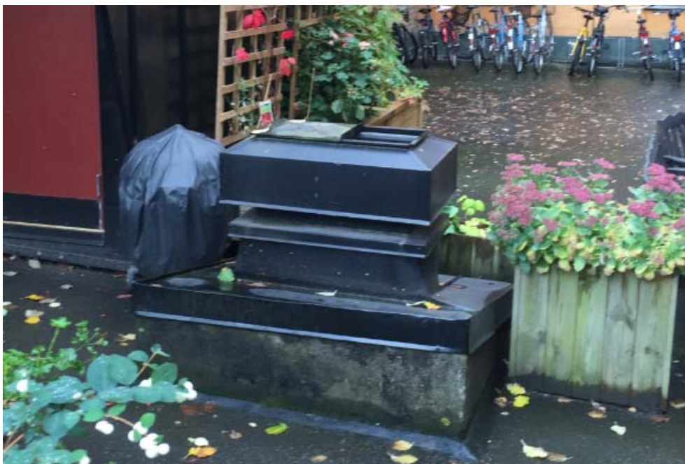
Figur 5. Källa S5, avluftshuv på innergård tillhörande Kv Nebulosan 26.
