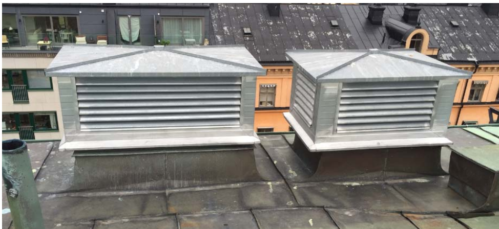
Figur 10. Källa S14(höger) och S15(vänster). Avluftshuvar på tak till Kv Nebulosan 32.
