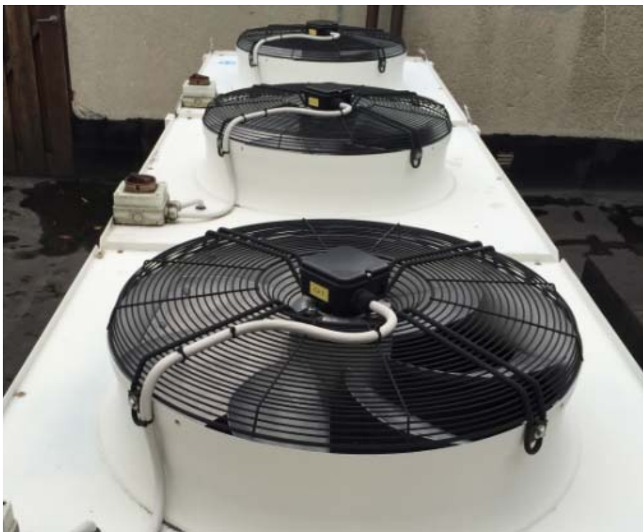
Figur 7. Källa S9, kylmedelkylare på tak Kv Nebulosan 33.
