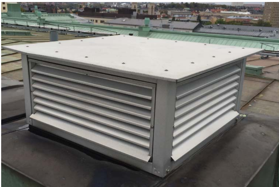
Figur 8. S11, avluftshuv på tak till Kv Nebulosan 33.
