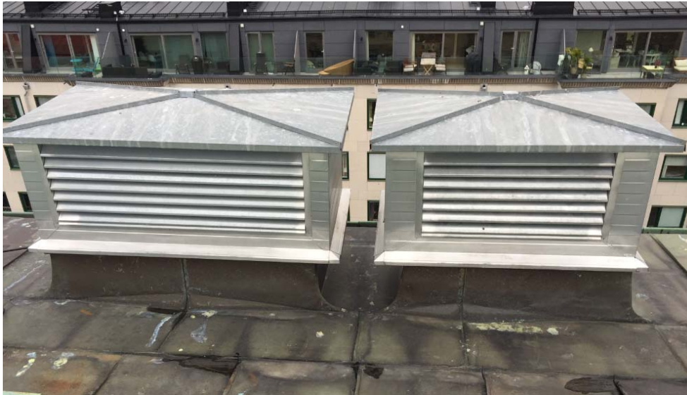
Figur 9. Källa S12(höger) och S13(vänster), avluftshuvar på tak till Kv Nebulosan 32.
