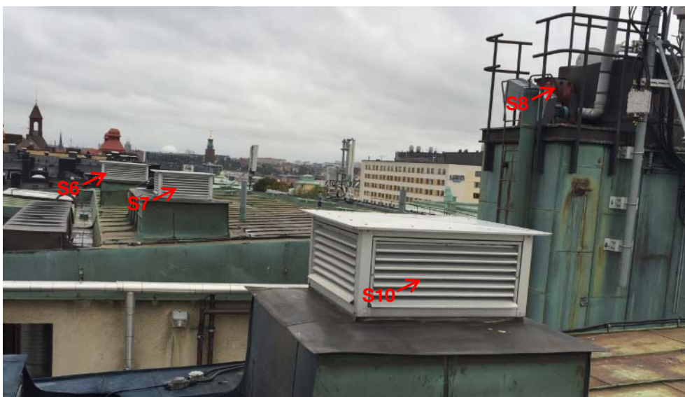
Figur 6. Källa S6-S8 och S10, avluftshuvar på tak Kv Nebulosan 33.
