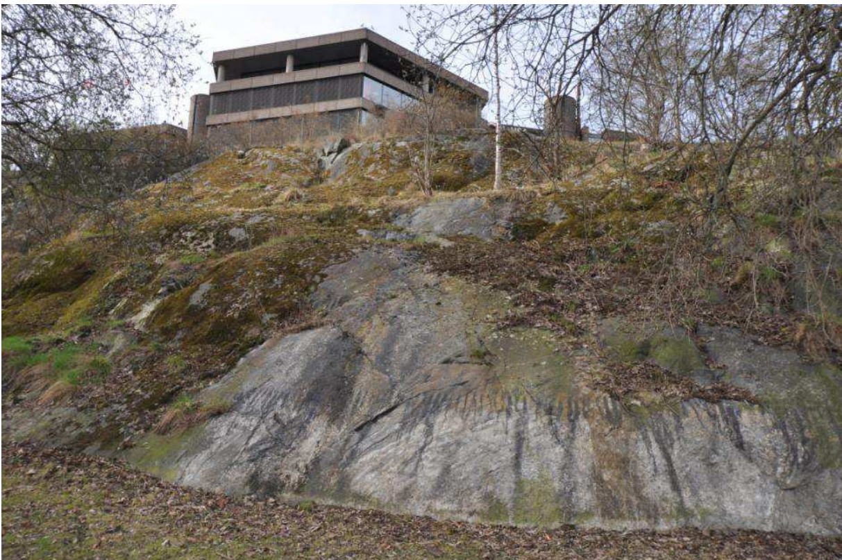
Figur 19: Bild tagen nordväster om huset. Inga observationer på skjuvzoner eller större förkastningssprickor som kan orsaka glidning av huset när bergpåkänningen ökar vid påbyggnad.
