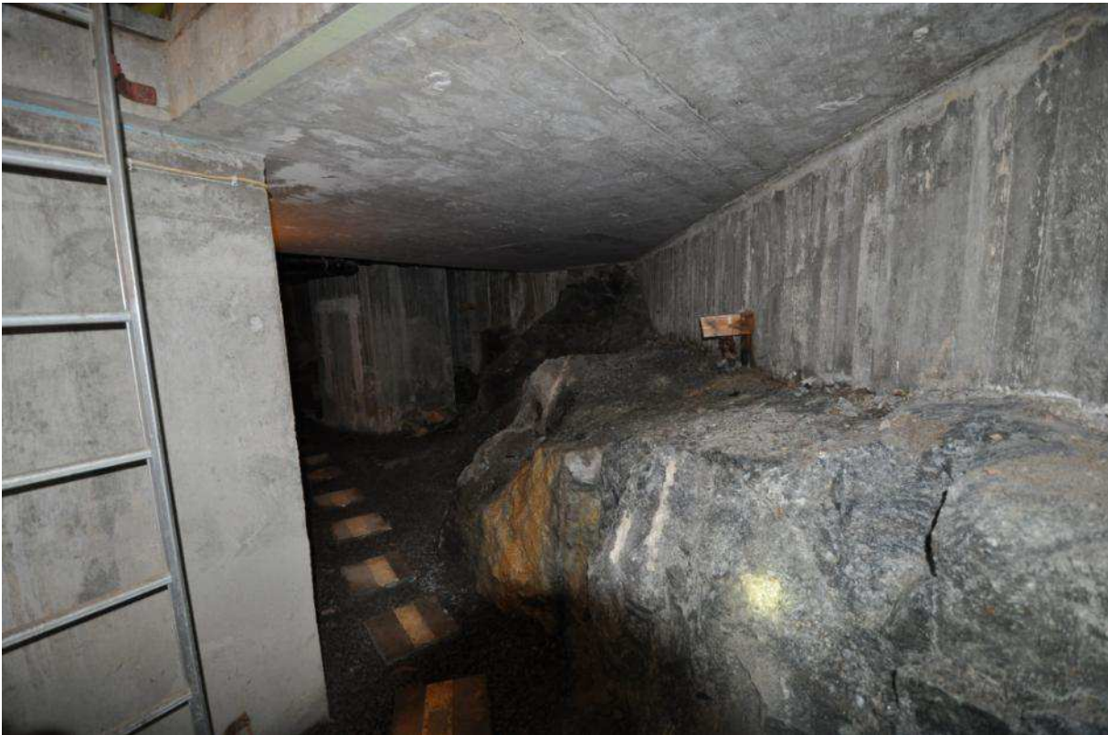
Figur 12: Grundvatten som trängs in i husgrunden tas om hand i detta område med pumpgrop.
