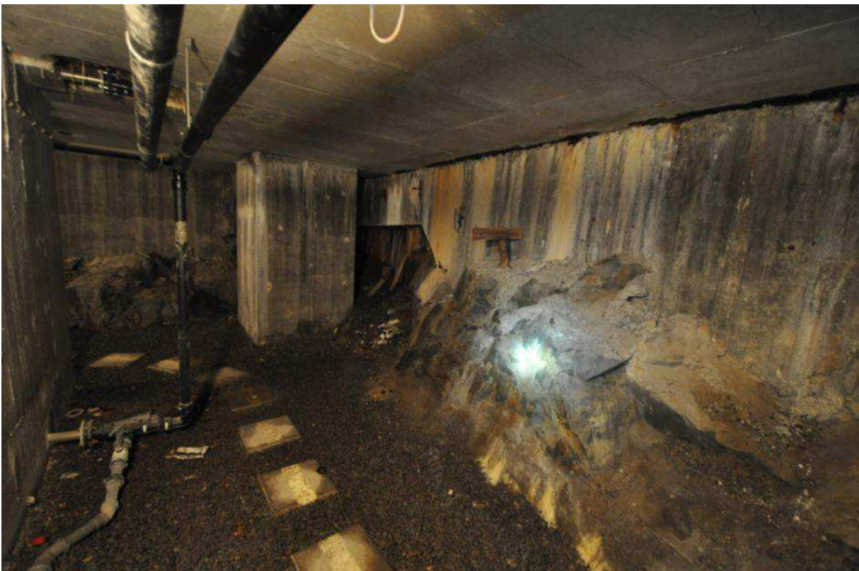
Figur 13: Bra bergkvalitet under gamla betongformar. Tät anslutning mellan betong och berg.
