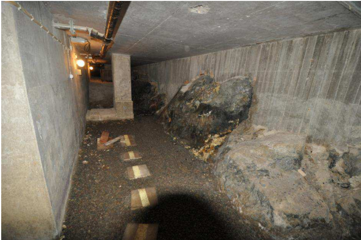
Figur 14: Berget har inte sprängts skonsamt och den slutliga schaktbotten är ojämn. Detta beror sannolikt mer på schaktmotod än bergets kvalitet.
