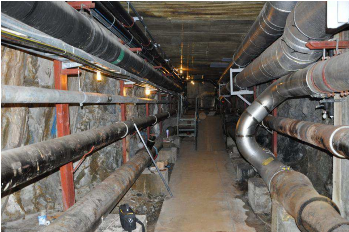
Figur 7: Bild tagen i bergtunnel mellan husets grund och Klara kanal för intag av vatten. Vid bomknackning upptäcktes flera bompartier på grund av sprickor som går parallella med tunnelriktningen.
