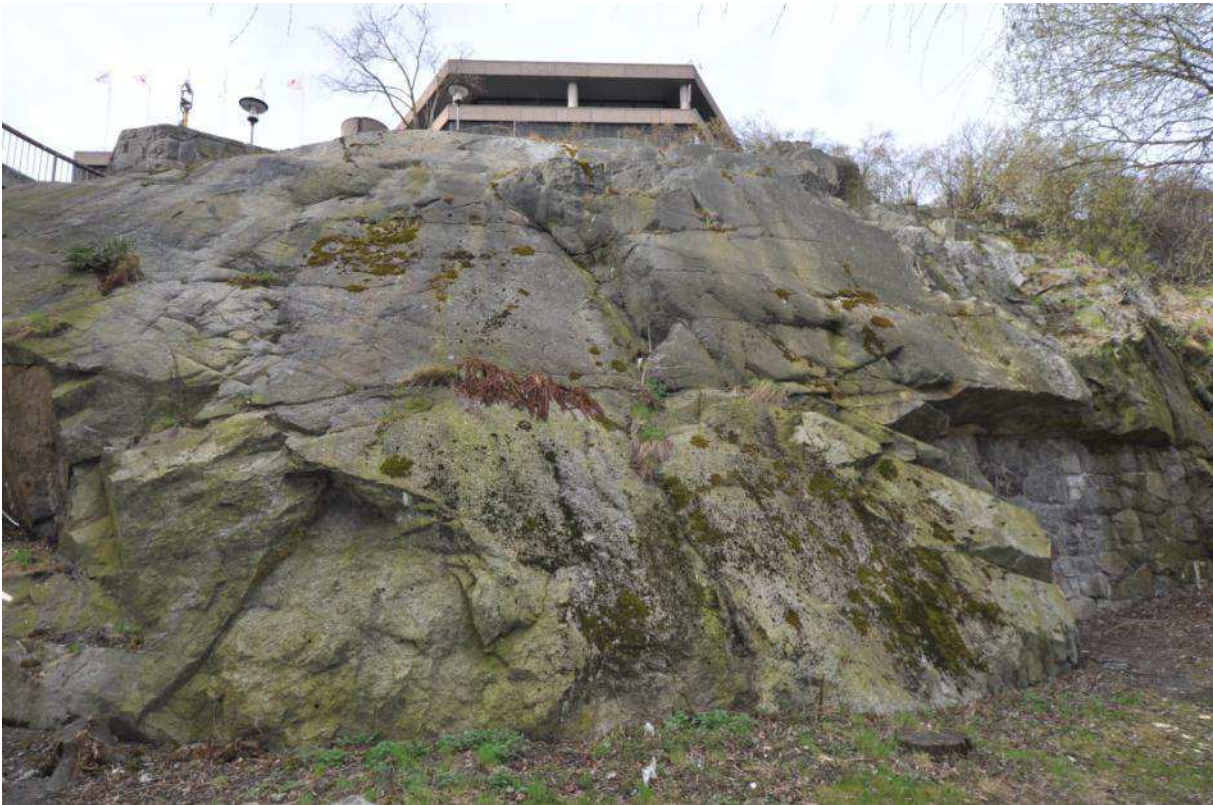
Figur 18: Bild tagen mellan bron och tunneln. Generellt bra bergkvalitet.
