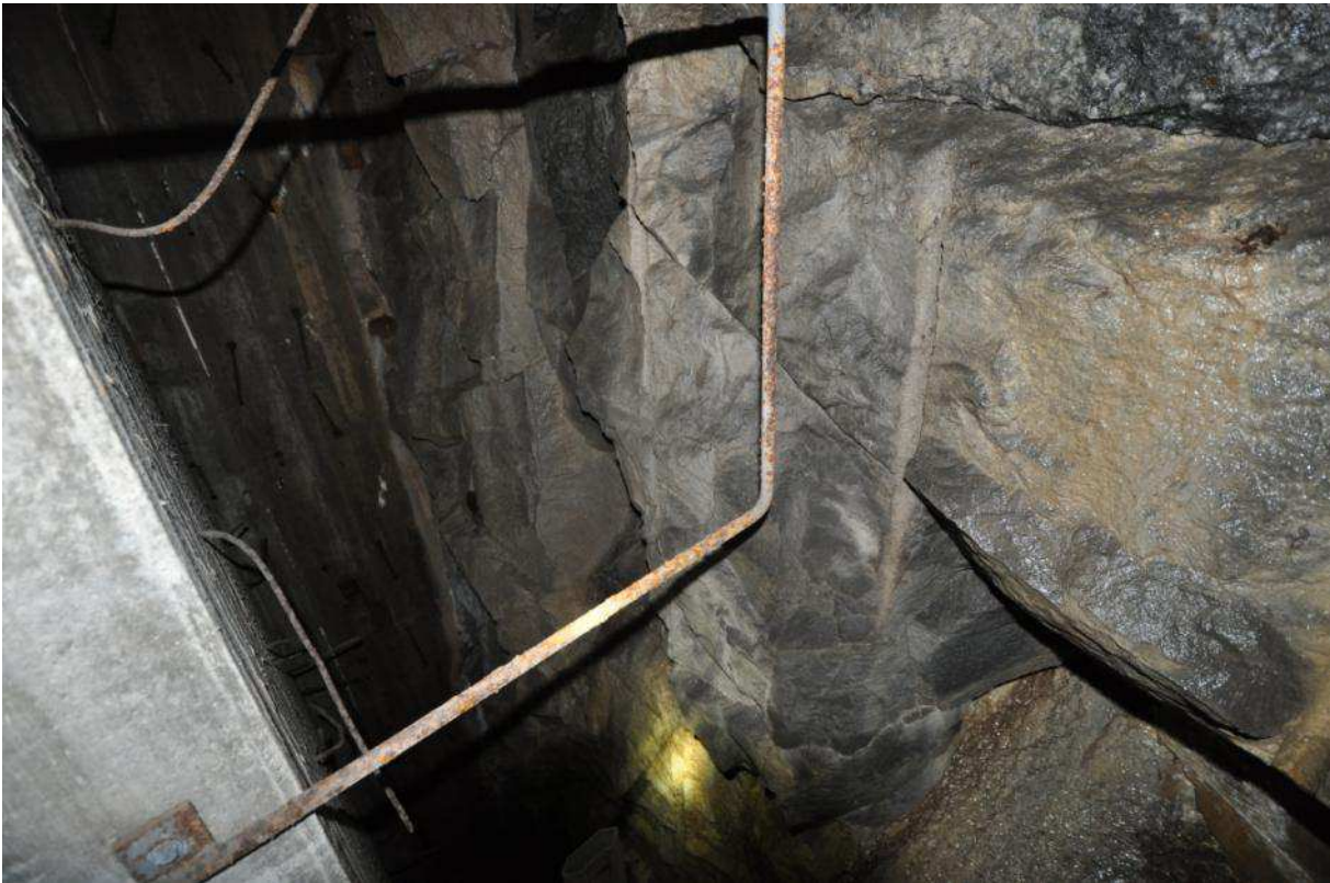
Figur 16: Grundvattnet tränger in i de få sprickor som fanns i denna del av bergschakten.
