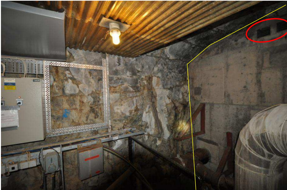
Figur 9: Bild tagen i bergtunnel mellan husets grund och Klara kanal för intag av vatten. Sämre bergkvalitet närmast tunnelpåslag klara sjö. Betongväggen motsvarar påslag i Figur 10. Röda cirkeln motsvarar ventilationsgaller på foton av både in- och utsidan av tunneln.
