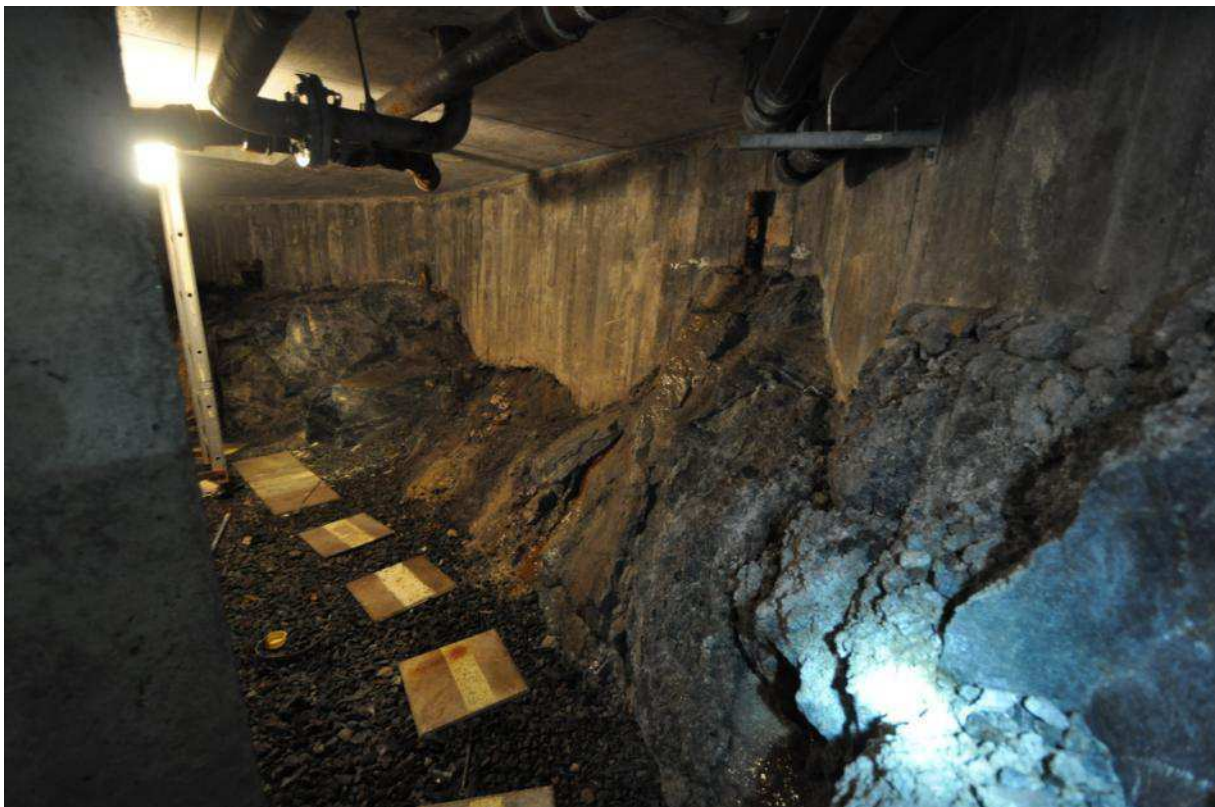
Figur 11: Bild tagen under bassängområdet. Strykning sprickor i berget mellan 010-25 och generellt brant orientering.
