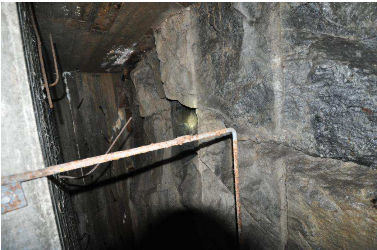
Figur 15: Bild tagen i bergschakt mellan grundmur och bergkontur. Skonsam sprängning har utförts med minimala skadezonutbredning. Få sprickor synliga och bra bergkvalitet.
