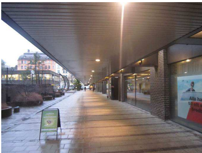
Det långa skärmtakets undersida är klädd med ursprunglig aluminiumpanel.
