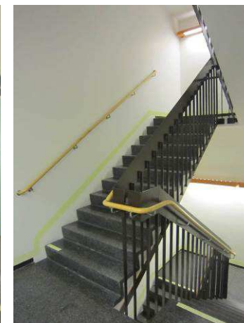
Trapphus C jämfört med Trapphus A (Brädstapeln 16) Smidesracket i trappa C har inte kvar den ursprungliga bruna kulören och lysrörsarmaturerna är utbytta.
