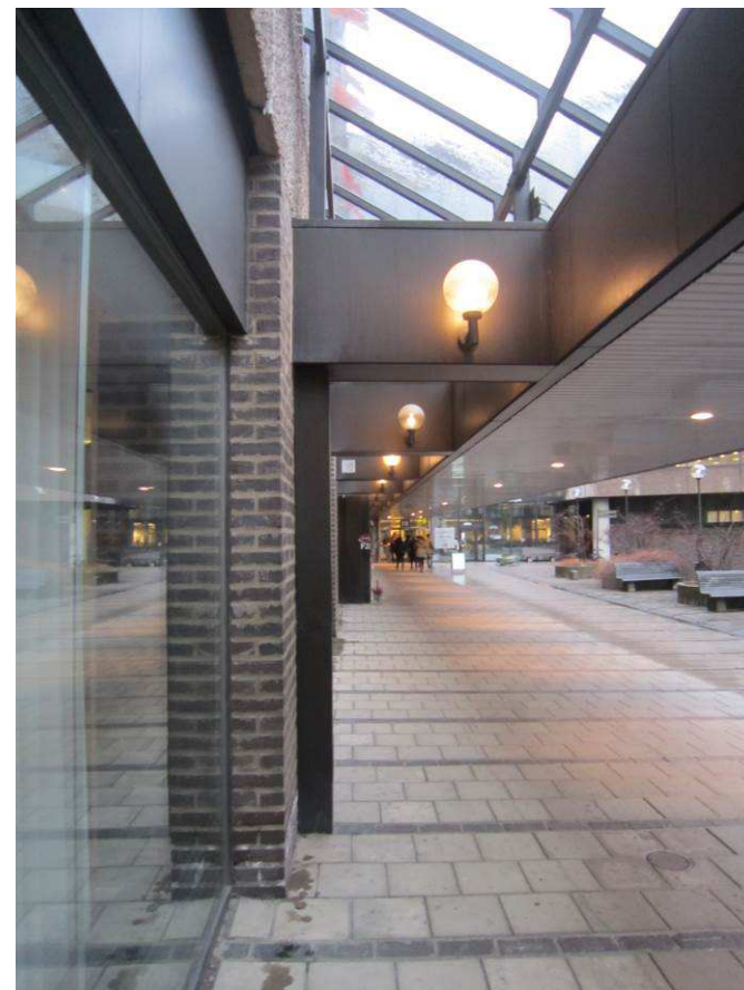
Skärmtakets konstruktion med plåtklädda balkar och lanternin i aluminium och glas.
