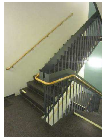
Trapphus C jämfört med Trapphus A (Brädstapeln 16) Smidesracket i trappa C har inte kvar den ursprungliga bruna kulören och lysrörsarmaturerna är utbytta.
