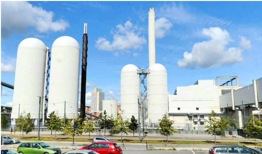
Figur 11. Bild på Hammarbyverket från tomten där gasblandningsstationen är placerad. Ackumulator-tankarna ses närmst Hammarby Allé.
