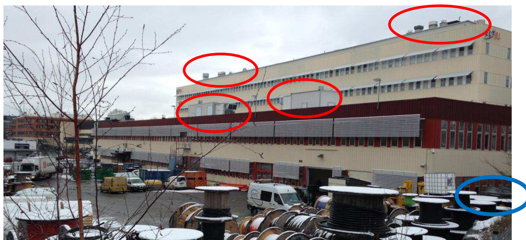
Bild 11. Archimedes 2 från sydöst. Fasta bullerkällor ventilation är markerade med röda ringar och kylmedelskylare med blå ring.
