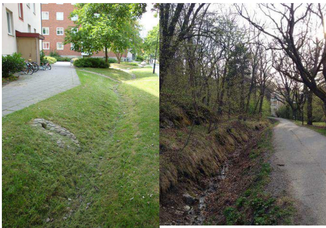
Figur 17. Exempel på utformning av svackdiken utan kantsten och avskärande dike i skogsområde.
