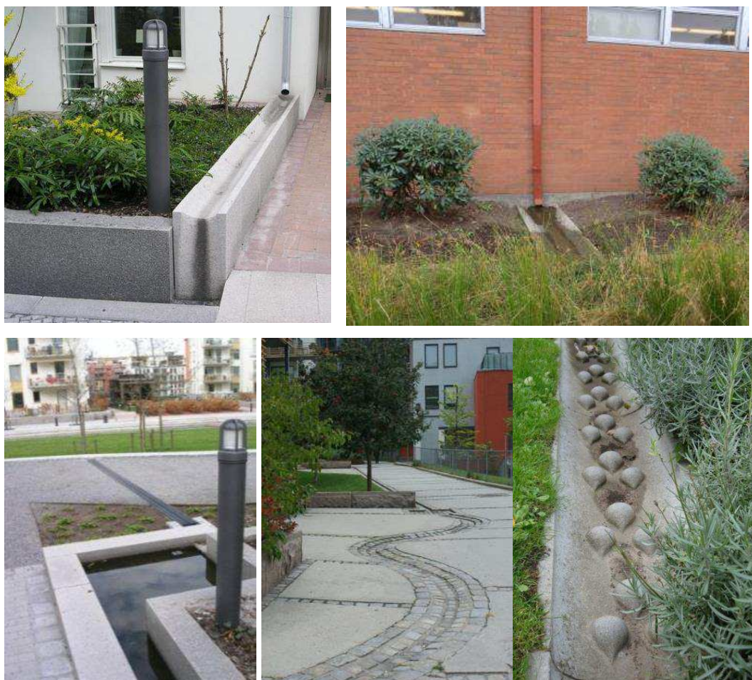
Figur 10. Övre bilderna ger exempel på stuprörsutkastare som ansluter till rännor. Nedre bilderna visar olika typer av rännor.
