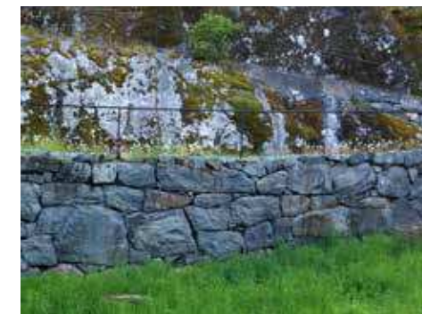
Kallmur placerad för att skapa en gångväg längs med en bergvägg.
