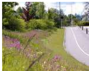
Slänt som ansluter mot natur från en gång- och cykelväg i Vislanda. Slänten har återställts med ängsfrö och örtpluggplanter.
