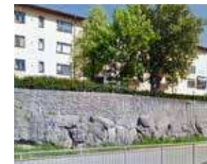
Bergskärning vid gång- och cykelväg och stödmur med beklädnadssten, vid Nynäsvägen.
