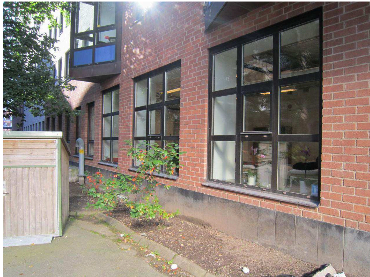
Fasad mot gården. Vid rivningen av lagerdelen lagades fasaderna på detta sätt på 1990-talet.
