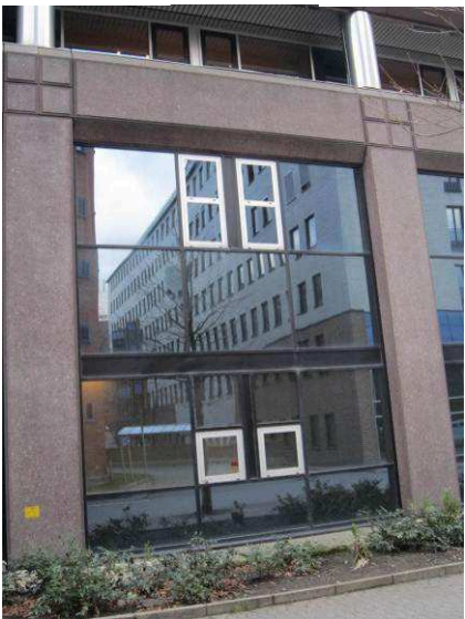
Fasadfack med aluminiumkonstruktioner.
