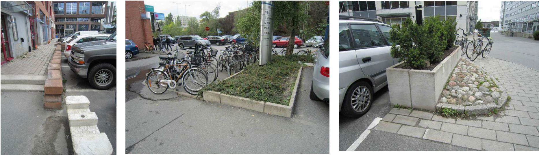
Stödmurar är ofta utförda av prefabricerade betongelement.
