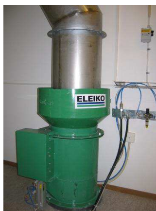
Bild 9, Sopventil under inkast (Eleiko AB)
