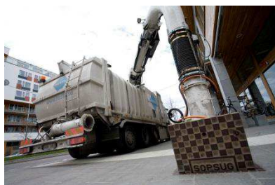
Bild 14, Dockningspunkt i trottoar vid tömning med sopsugbil. (Envac AB)
