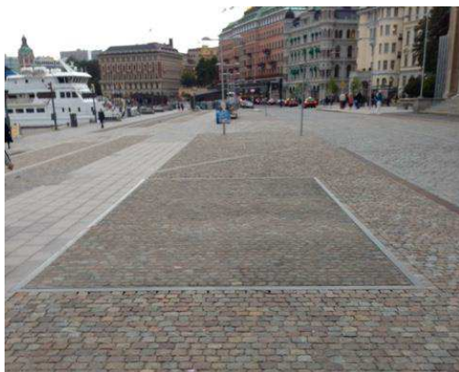
Bild 10 Markförlagd terminal för en fraktion. Terminaltaket är körbart. (Envac AB, Stömkajen)
