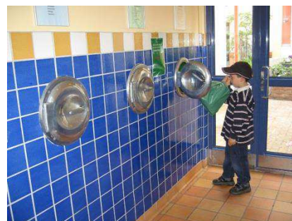
Bild 12, Väggmonterade inkast placerade inomhus. (Envac AB)
