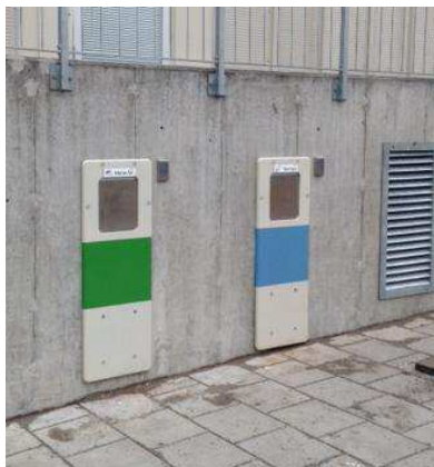
Bild 7, Väggmonterade inkast placerade utomhus. (MariMatic AB)
