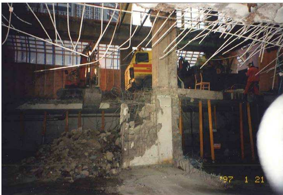
Vid ombyggnaden 1996-97 utfördes stora ingrepp i stommen. Här mellan plan 3 och 4. Källa: Nordea
