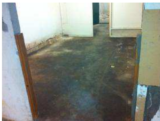
Bild 2. Petroleumkontaminering av betongplatta.
