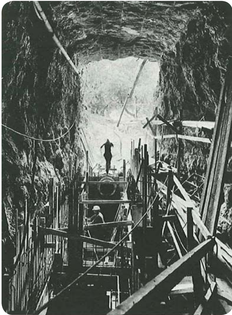
Kulvert för kylvattenledning från Barnhusviken. Anledningen till att den är så omfattande i storlek är att den även användes för kommunikation under bygget.
