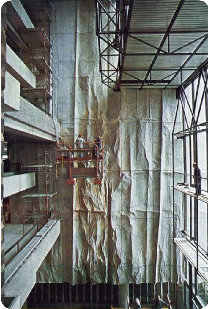
Entréhallens konstnärliga utsmyckning under uppförande. 75 betong-element har fogats samman till en reliefvägg.
