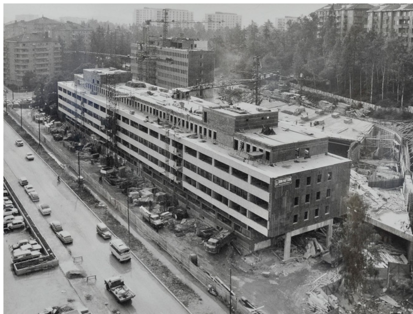
Figur 55 – Foto från byggtiden på 1960-talet som visar bergskärning varemot betongväggar göts med ett mellanrum, från kulturmiljökonsekvensbeskrivning (Tyréns Sverige AB, 2024).
