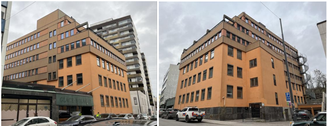
Bild 1 och 2. Byggnadens två olika tillkomsttider är väl synliga i fasaden, ursprunglig del av puts, tillbyggnad från 1970-talet i tidstypisk plåt.
