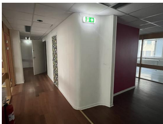
Bild 10 och 11. Ursprungliga träfönster med beslag samt fönsterbänkar av mörk sten är bevarade. Rester av ursprunglig planlösning med arkivrum/våtrumsgrupper med rundade hörn finns bevarad på plan 4.
