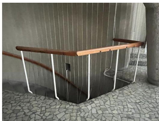
Bild 6 och 7. Entréhallens ursprungliga utformning med golv av stenmosaik, svängd trappa av marmor samt dekorativt räcke är huvudsakligen bevarad.
