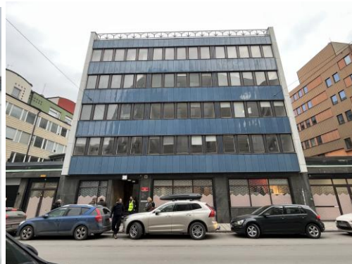
Bild 1 och 2. Långsidans fasad är uppdelad i en putsad del och en del med blåmaljerade plåtkassetter. Den översta våningen är indragen och klädd med koppartak.
