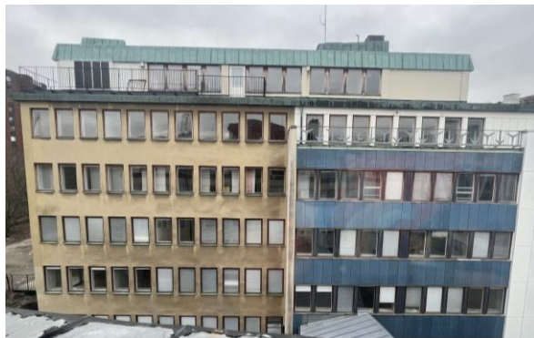
Bild 1 och 2. Långsidans fasad är uppdelad i en putsad del och en del med blåmaljerade plåtkassetter. Den översta våningen är indragen och klädd med koppartak.
