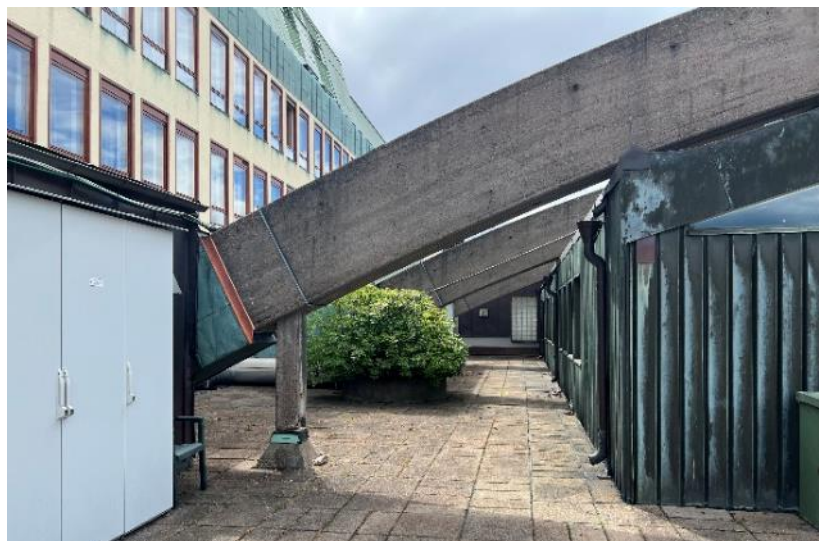
Välvda betongbågar på takterrassen.
