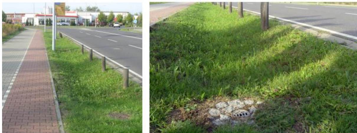
Figur 16 Exempel på infiltrationsstråk i gatumiljö. I den högra bilden syns bräddbrunnen som är placerad några decimeter över stråkets botten. ©WRS.
