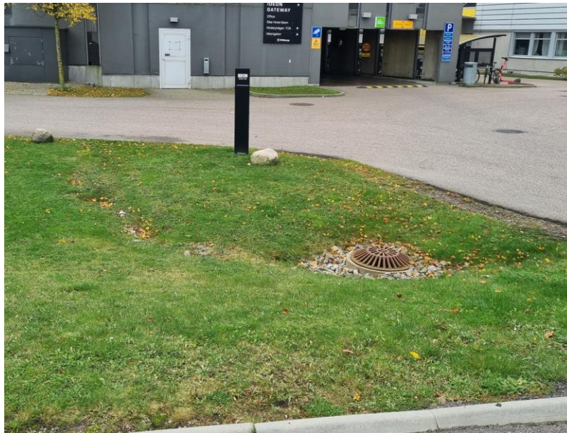
Figur 25 Svackdike med stenkrossdike och bräddavlopp
