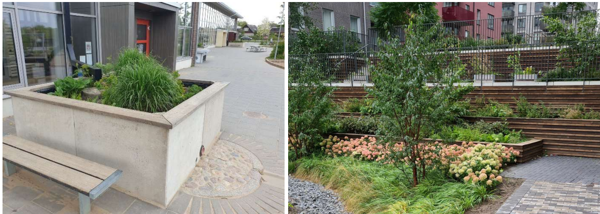
Figur 21 Upphöjd växtbädd placerad från fasad, med erosionsskydd, som tar emot takvatten och släpper ut vattnet ytligt till ränna (Dalby) (t.v.). T.h. visas terrasserade växtbäddar i trapp som kan ta emot dagvatten från hårdgjord gårdsmark (Hammarby Sjöstad)
