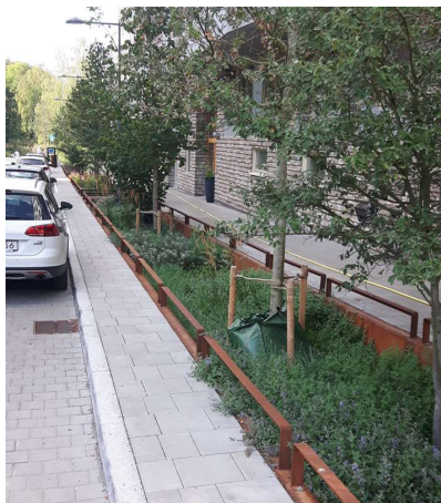
Figur 22 Nedsänkta växtbäddar som tar emot dagvatten från omgivande hårdgjord mark med avrinning över kant, samt från väg med hjälp av brunn med koppling till växtbädden
