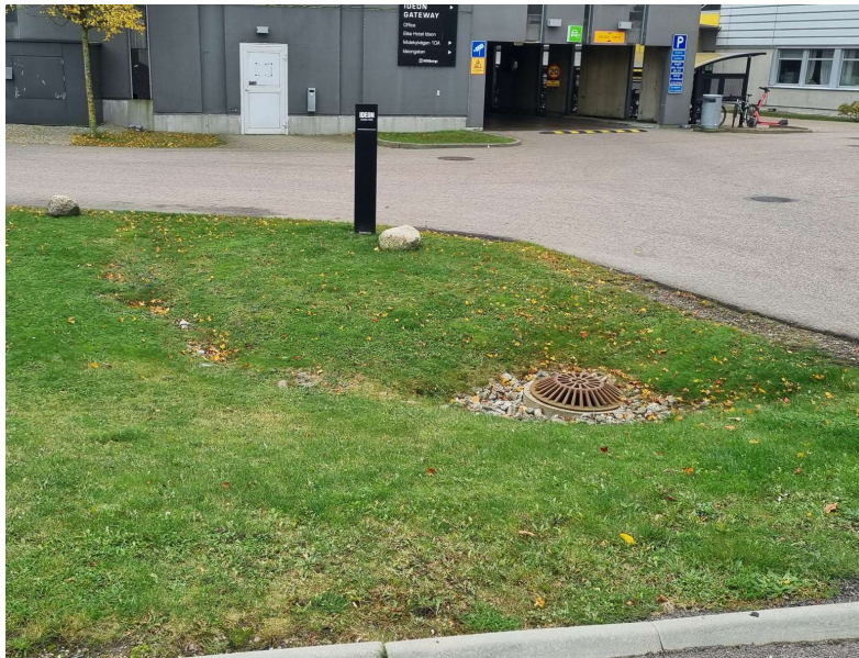
Figur 24 Svackdike med stenkrossdike och bräddavlopp
