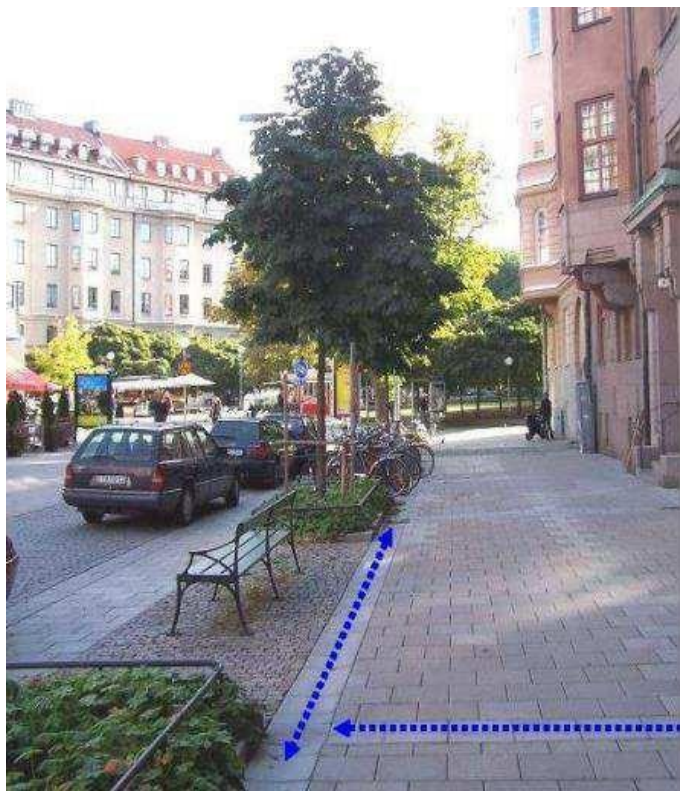
Figur 19. Exempelbild av hur takvatten kan avledas i rännalor till växtbäddar med en gemensam underliggande växt- och infiltrationsbädd (skelettjord) för träd (Foto av Örjan Stål och Björn Embrén).
