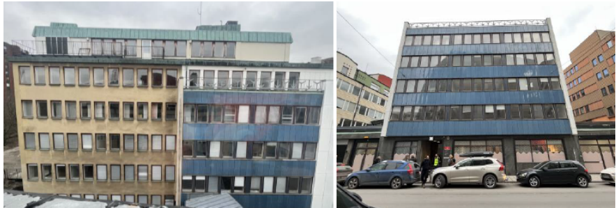
Bild 1 och 2. Långsidans fasad är uppdelad i en putsad del och en del med blåemaljerade plåtkassetter. Den översta våningen är indragen och klädd med koppartak.
