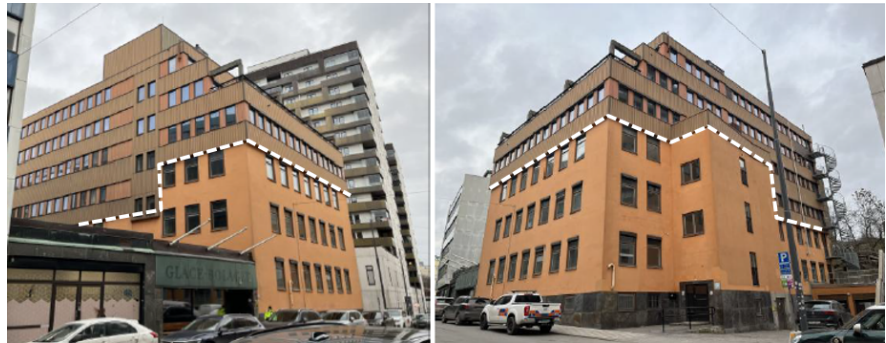
Gladan 5 sett från Warfvinges väg. Byggnadens två olika tillkomsttider är väl synlig i fasaden. Ursprunglig del är putsad och tillbyggnaden är utformad med plåt. Vit linje illustrerar gränsen mellan den nedre ursprungliga byggnadsdelen och den övre tillbyggnaden från 1971.
