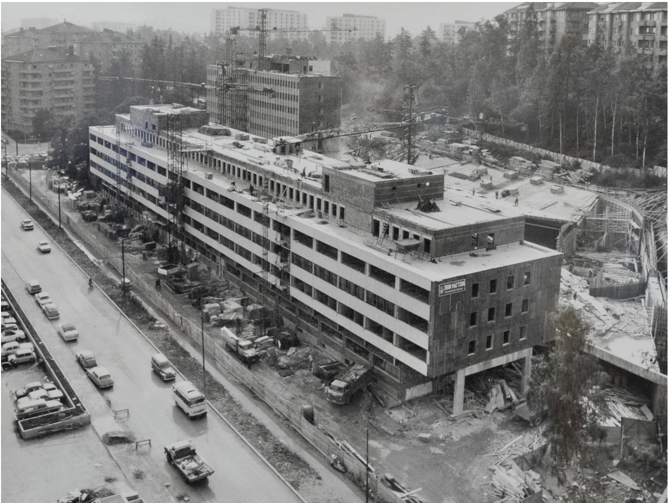
Foto från byggtiden på 1960-talet som visar bergskärning varemot betongväggar göts med ett mellanrum. Träden i slänten skyddades bakom plank. Källa: Handelsbanken.
