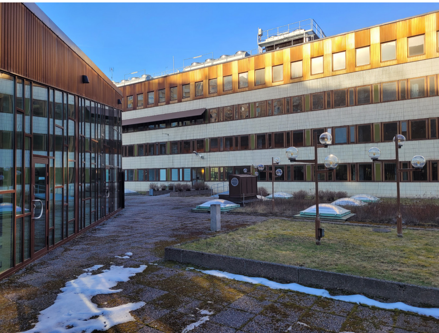
Takvåningen sedd från gården. Mot söder livar den med övrig fasad. Aluminiumpanelen har åldrats ojämnt.
