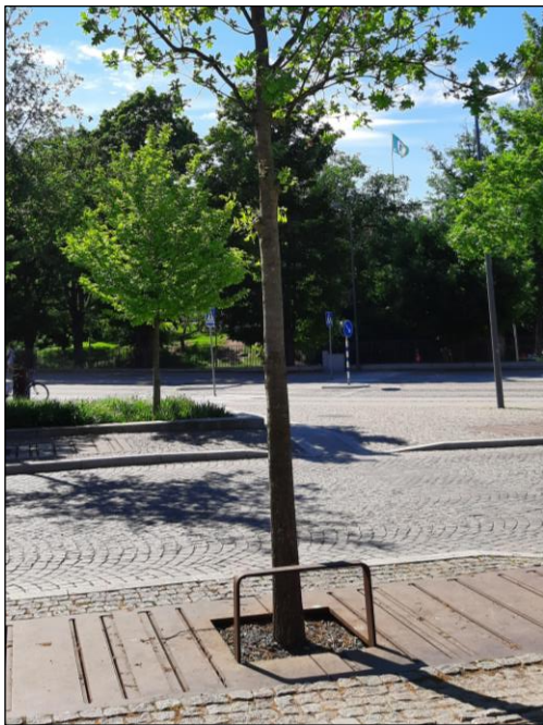
Figur 21 Trädplantering i skelettjord, med en mindre öppning för vatten att rinna ner. Foto: NIRAS
