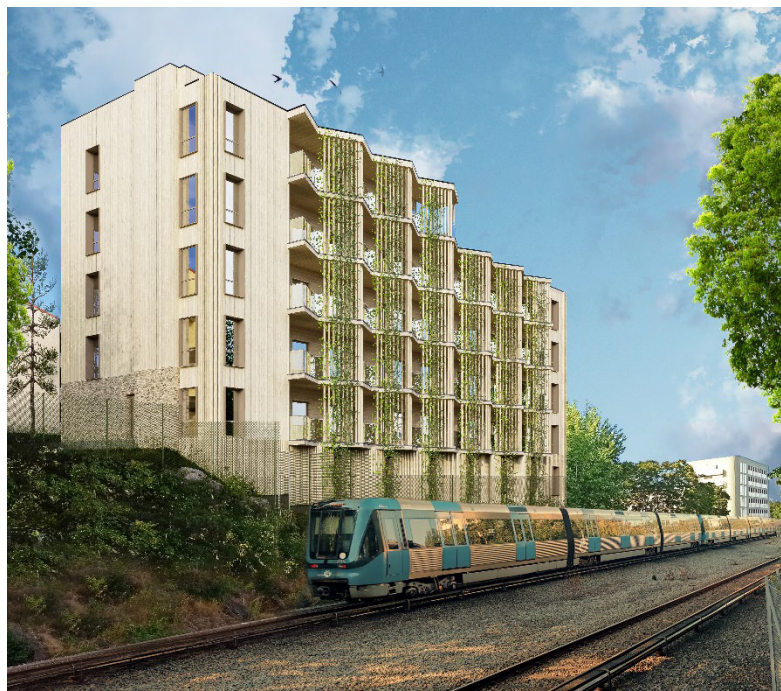
Fasad mot öster. Den veckade fasaden mot tunnelbanan syftar till att skapa dynamik och djupverkan. Träribborna i veckningen kan fungera som klätterställning för växter. Bild: Lundberg Aguilera Arkitekter
