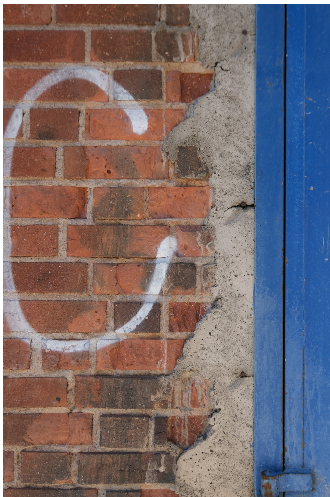
Skadat tegel i anslutning till en sekundärt insatt dörr.
