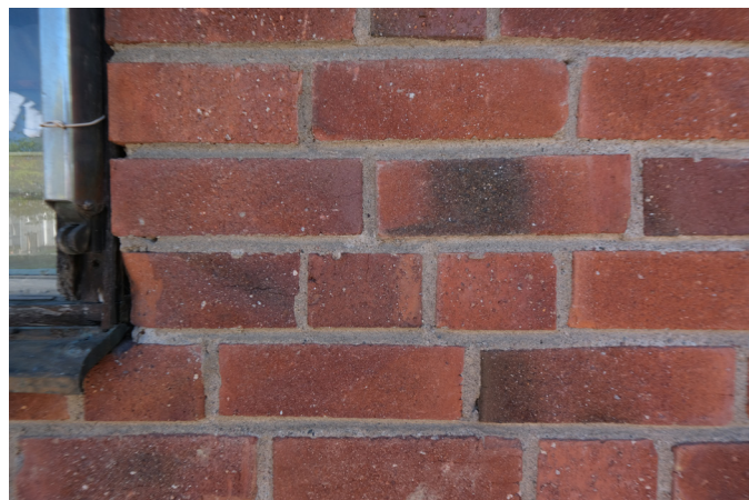
Tegelparti på södra fasaden. Teglet skiftar i kulör och har en sandad yta, vilket innebär att det gavs en struktur vid tillverkningen genom att man sandade de strängpressade stenarna innan bränning.
