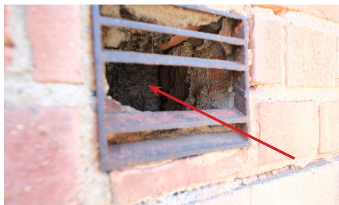
Innanför ett ventilationsgaller är träullsskivan synlig (markerad med röd pil).
