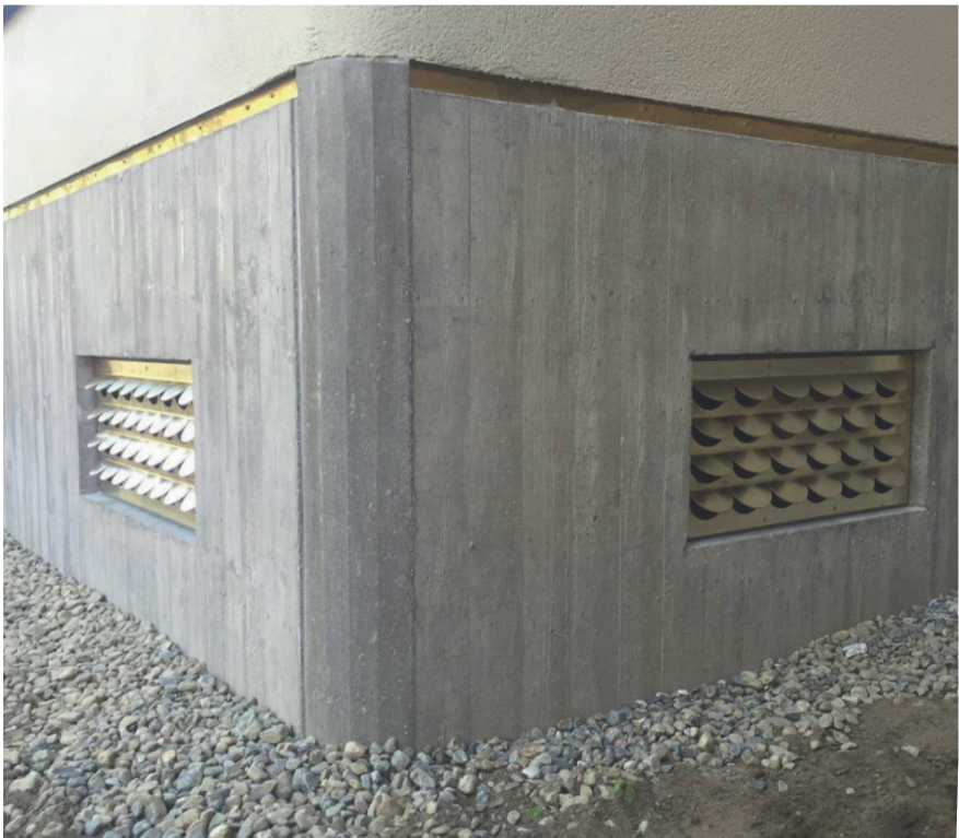
Brädgjuten betong i sockel.
