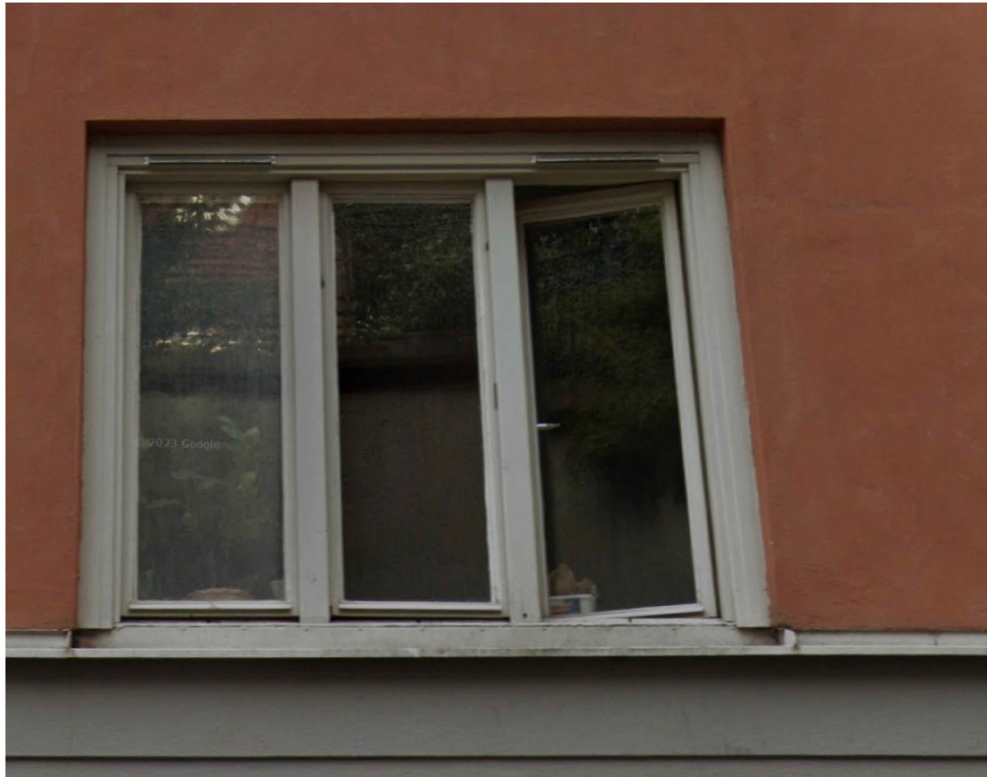
FOTO BEFINTLIGT FÖNSTER PLAN 4.1 TR - TRE LUFT MED MITTPOST, INÄTGÄNDE - SOM ERSÄTTS MED NYTT HÖGRE FÖNSTER
