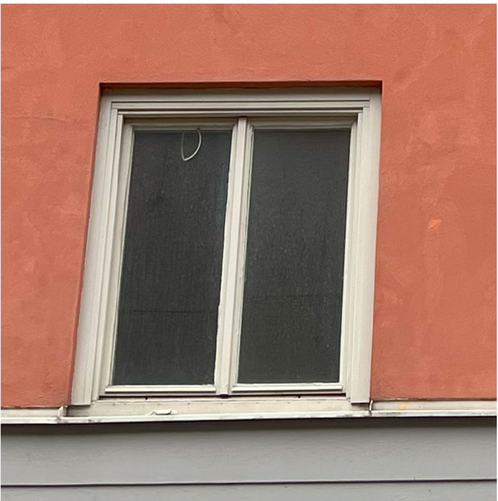
FOTO BEFINTLIGT FÖNSTER PLAN 4.1 TR - TVÅ LUFT UTAN MITTPOST, INÄTGÄNDE SOM ERSÄTTS MED NYTT HÖGRE FÖNSTER
