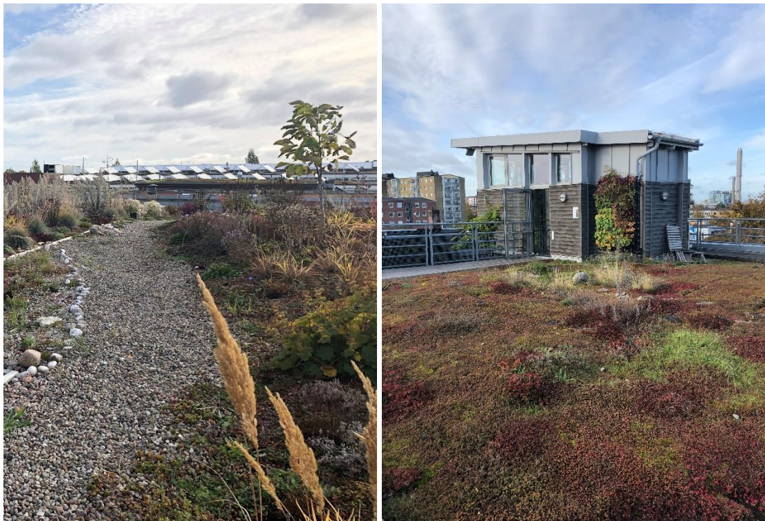
Figur 22. Sedumtak kan anläggas på bostadshus och terrasser. Foto: Bjerking AB.
