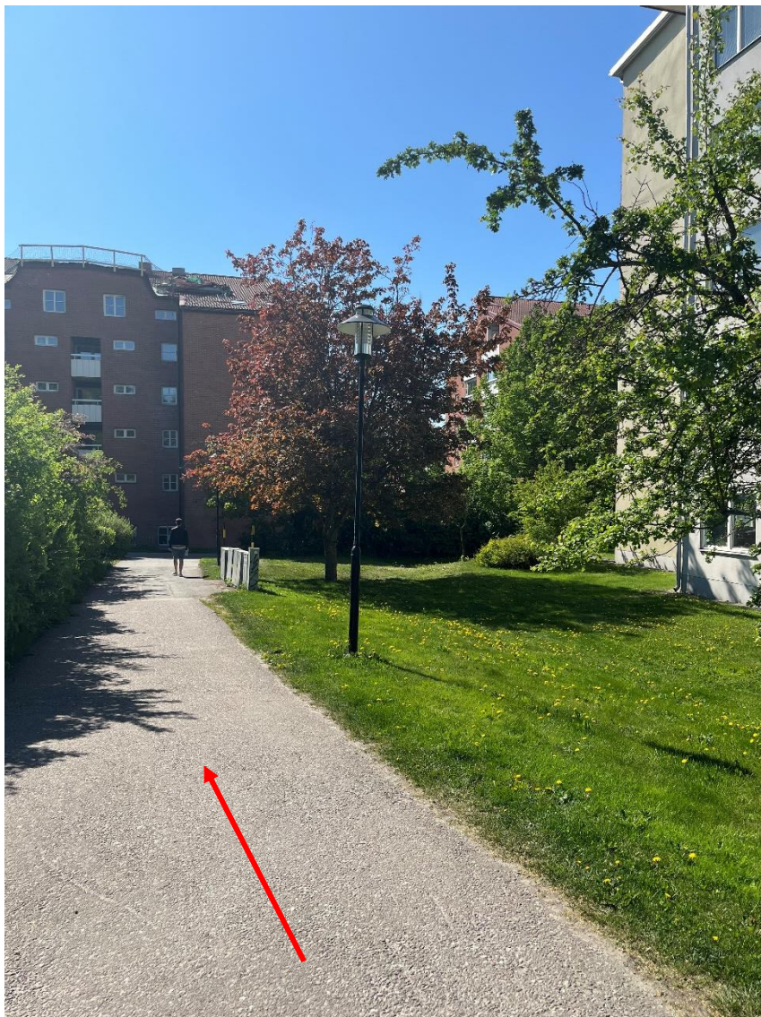
Figur 15. Trottoar som transporterar dagvatten nedströms vid skyfall. Flödesriktning redovisas med röd pil.
