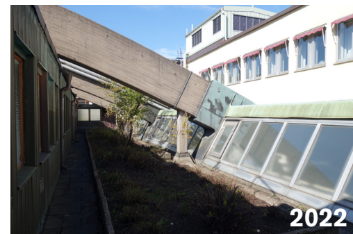
Lanterninerna med trådarmerat glas förser Kongresshallens foajé med dagsljus.
