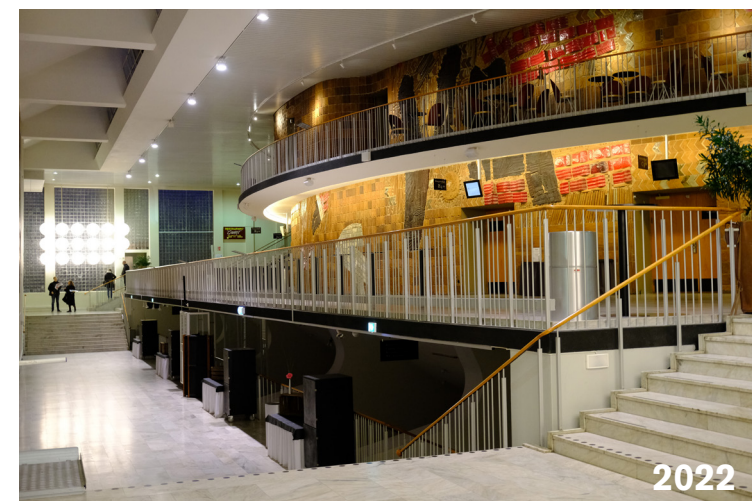
Den stora förändringen är att bärande betongbågar målats vita och att infällda spotlights ersatts med utanpåliggande armaturer. Ursprungliga räcken är bevarade.
