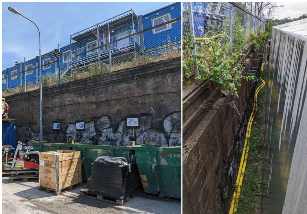
Figur 5. Bilderna visar lastkajen till den f.d. soplastningsstationen, sett från tidigare spårområde (till vänster) och från själva lastkajen (till höger). Lastkajens höjd är ca 4,4 meter från banområdet. Som det syns på vänstra bilden består lastkajen av en mur till ca 2,4 meters höjd och sedan av betong.
