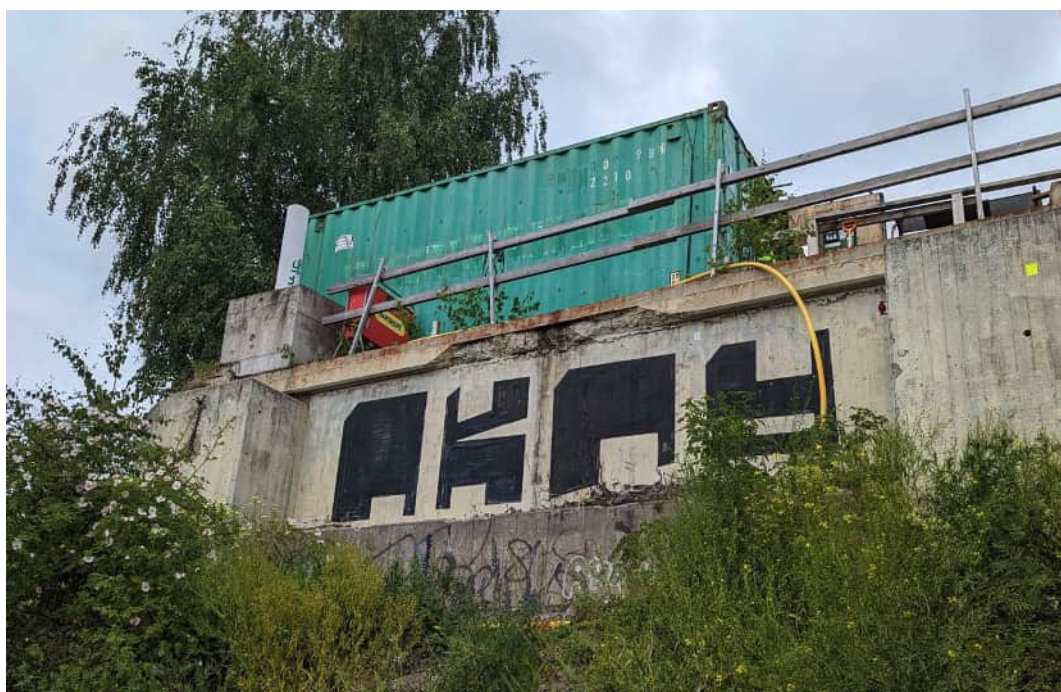
Figur 6. Brostöd i betong som var del av f.d. bilvägsbro över banområdet. Konstruktionen används idag som upplagsyta för tunnelbanebygget.
