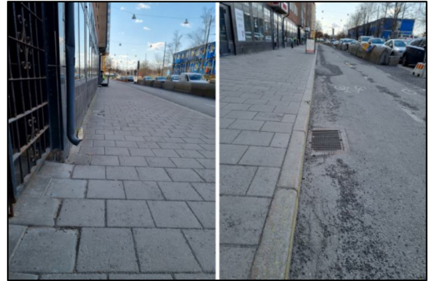
Figur 34. Stuprör med utkastare som avleder dagvatten från takytorna ut på gatan till vänster i bild och rännstensbrunn i cykelbanan till höger i bild. (Norconsult, 2024)
