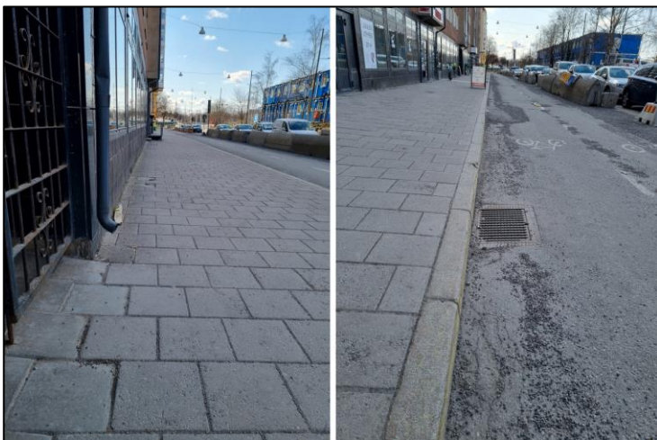
Figur 12. Vänster: Stuprör med utkastare som avleder dagvatten från takytorna ut på gatan. Höger: Rännstensbrunn i cykelbanan
