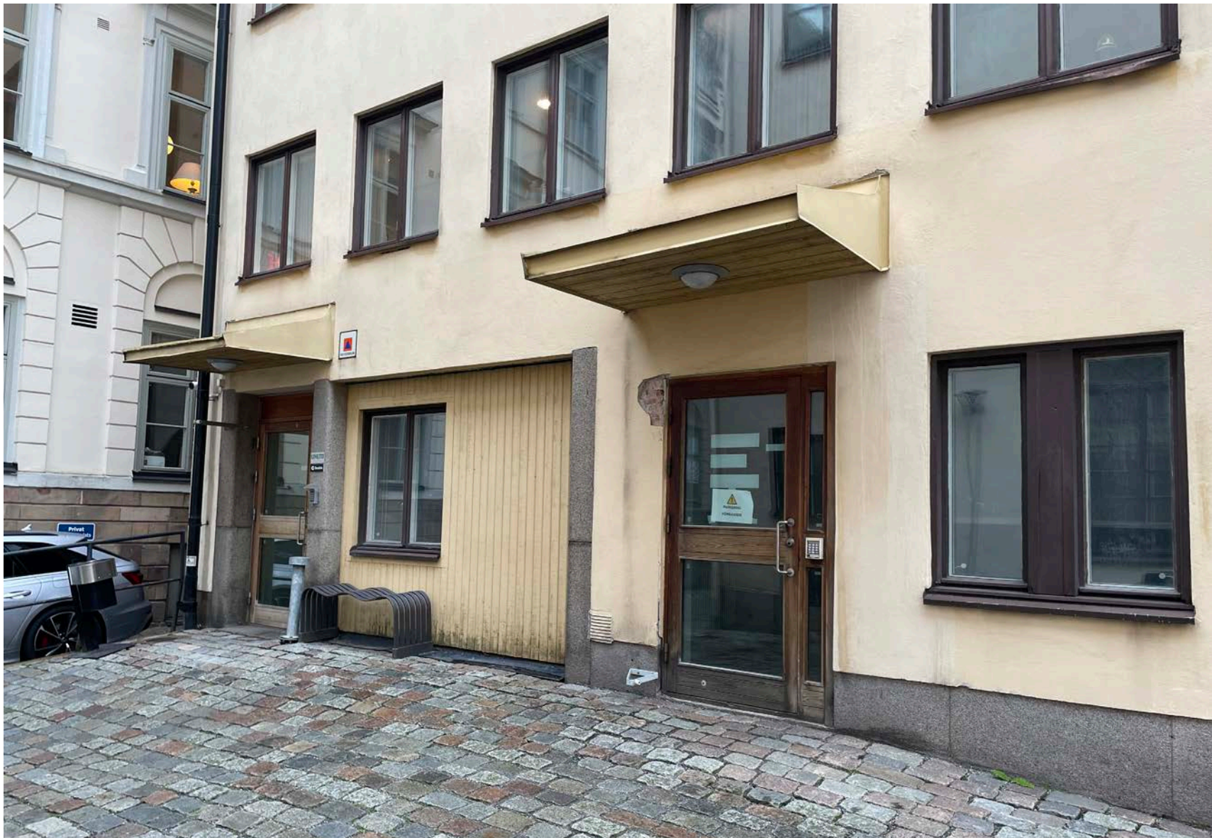
Entréportar i södra flygelns gavelfasad mot öster. Garageport har satts igen med stående panel. Skärmtaken är sentida.
