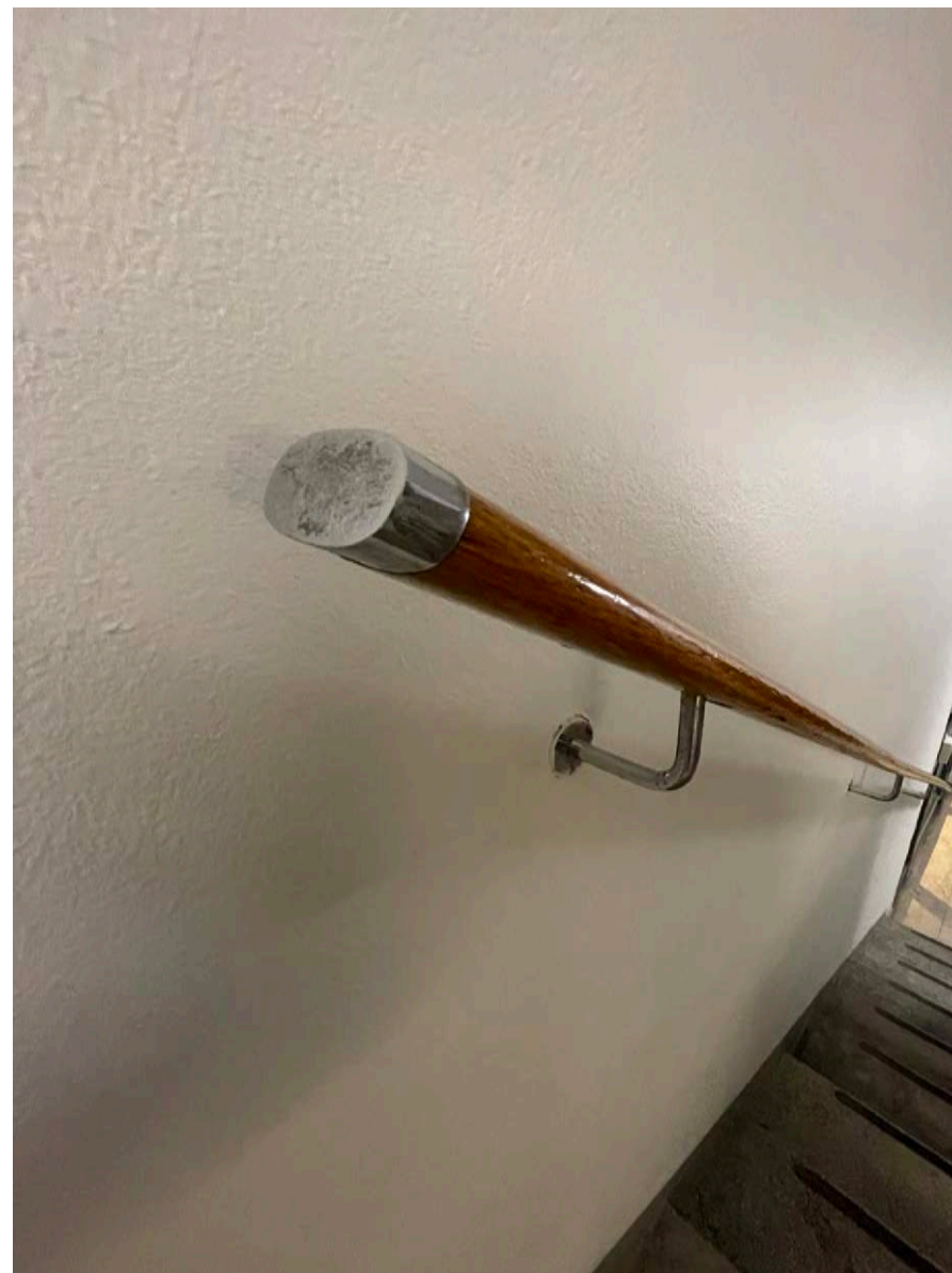
Del av trapppräcke, oval handledare i ädelträ med kromat avslut.
