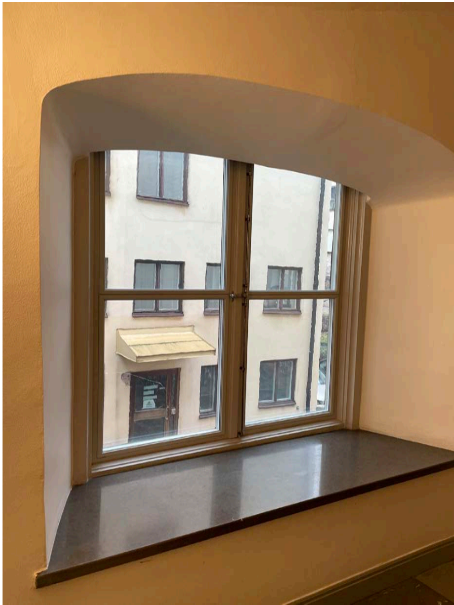
Fönster i trapphus. Innerbågarna har försetts med tilläggsrutor för förbättrad energi- och bullerprestanda.
