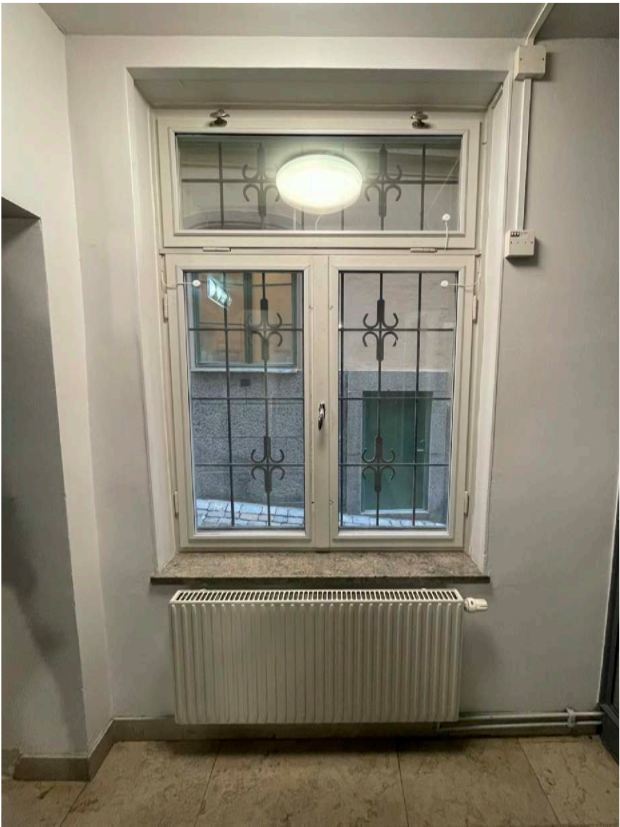
Fönster i trapphus, Hus 2. T-postfönster med tilläggsrutor och utvändigt galler.
