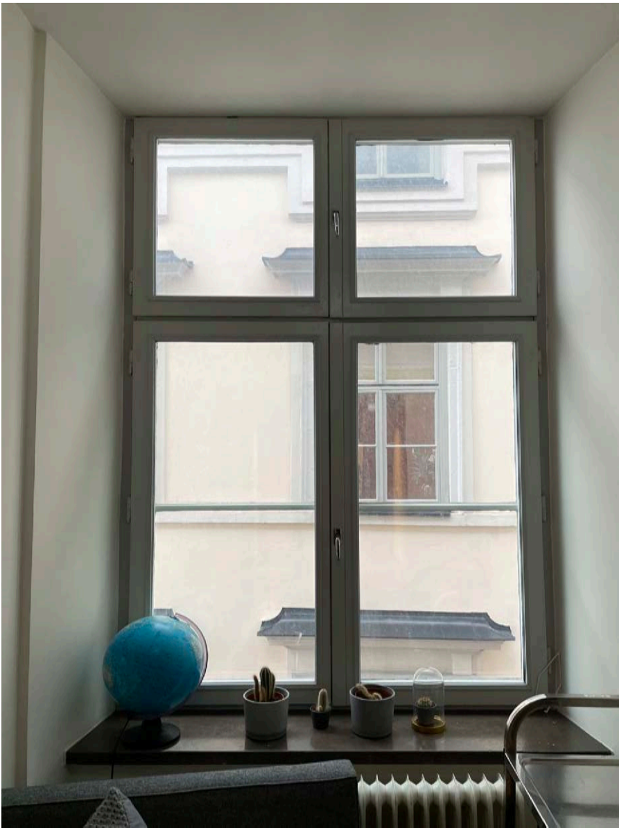
Fönster i korridor mot Tullgränd. Fyrlufts-fönster med spröjs i ytterbågen och infälld spanjolett, 1900-talets mitt.
