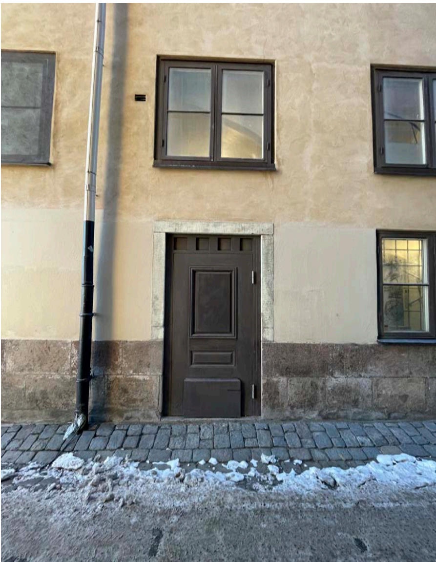
Entrédörr på gavelfasad mot Packhusgränd. Delar av blindfönster syns till vänster i bild. Dörrsnickerierna är från tidigt 2000-tal.
