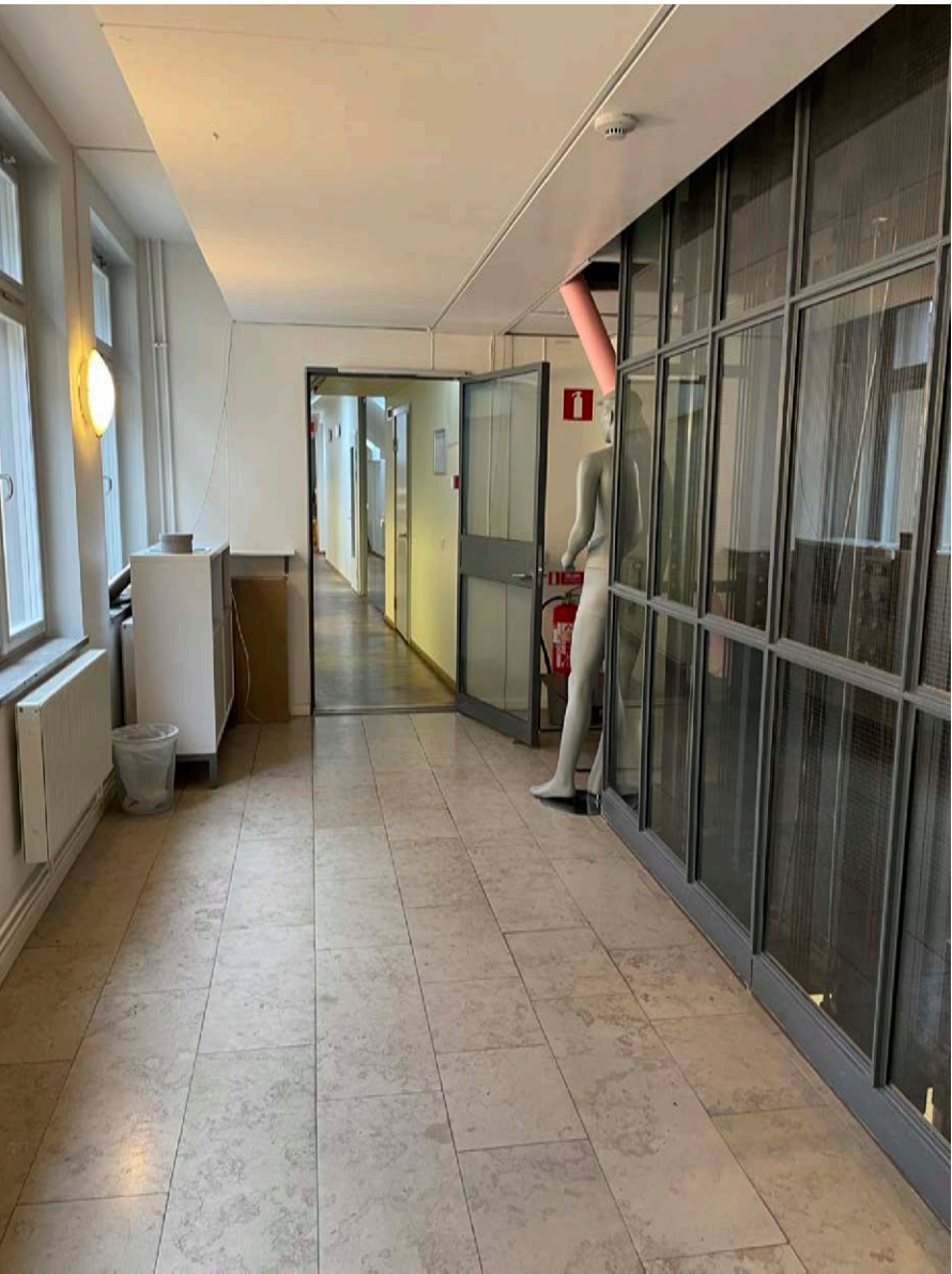
Mötet mellan trapphuset och korridor. I såväl dörr- som hisspartier sitter sedan länge trådglas av brandskäl.
