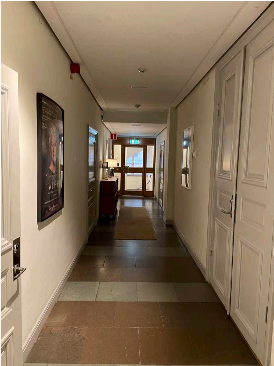
Korridoren på vån 2 tr har en liknande karaktär som på planet under. Glaspartier har tillkommit mot trapphus för att tillgose brandkrav.
