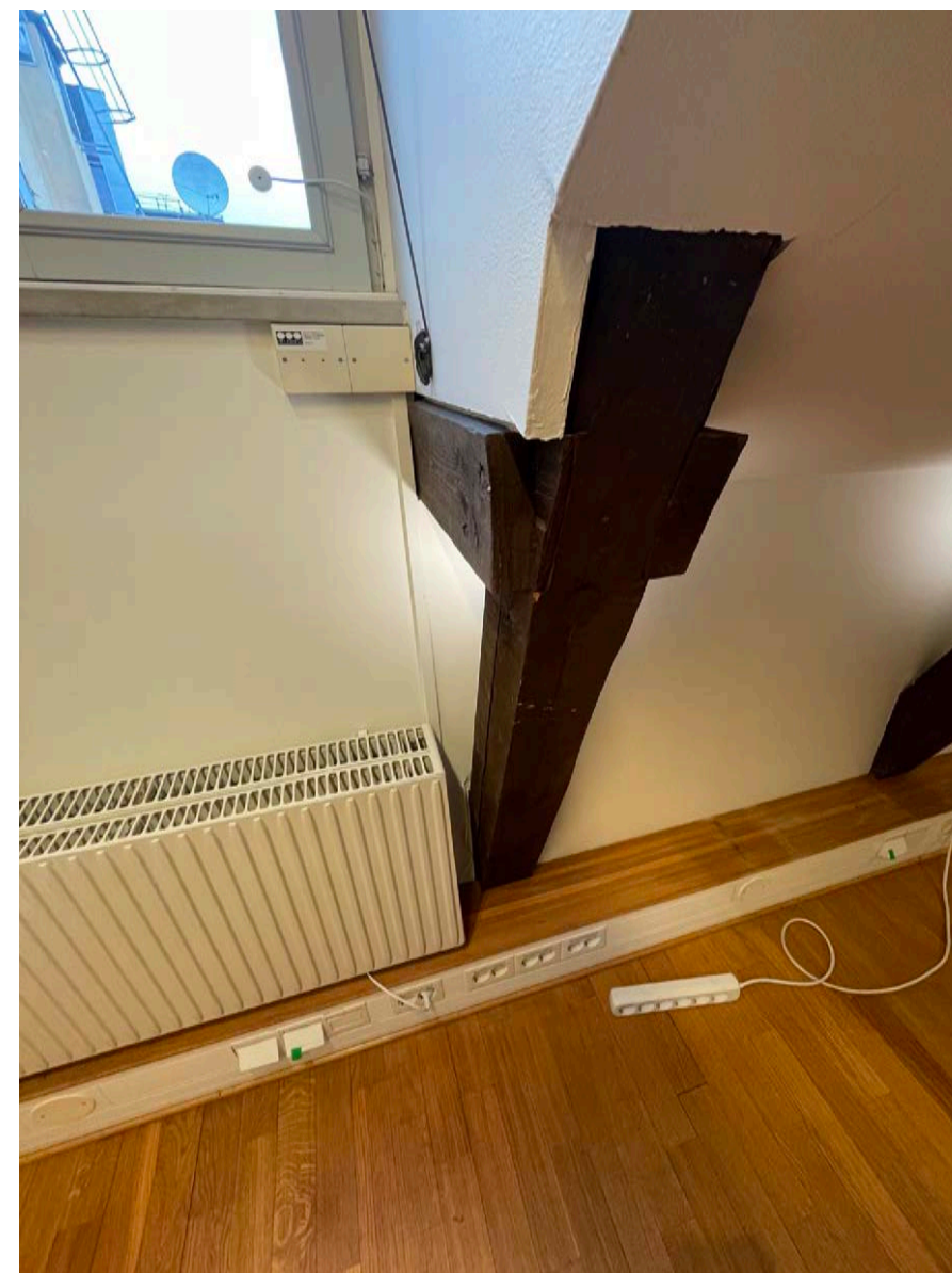
Vindsvåning i södra flygelm, del av takstolskonstruktion med stödben och tass.
