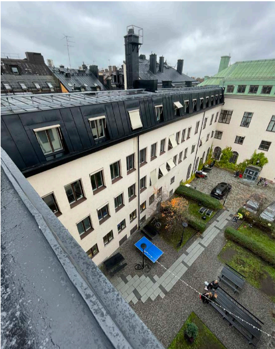
Fasader mot innergård där den norra delen har regelbunden karaktär medan det i 1700-talsdelen närmast Stora tullhuset är mer brokigt. Översta våningsplanet är infällt i takfallet.
