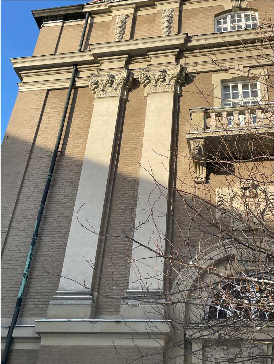
Pilastrarna har i vissa fall slätputsats, de var slammade i ursprungsutförandet.
