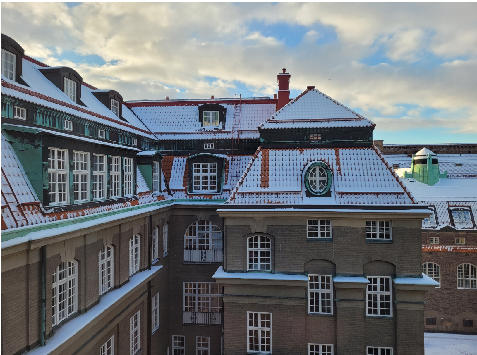
Vy över östra flygelbyggnadens tak. Den vertikala delen i säteritaket, den som avskiljer de två takfallen, är klädd i koppar och rymmer fönster som delvis är från 2000-talet.
