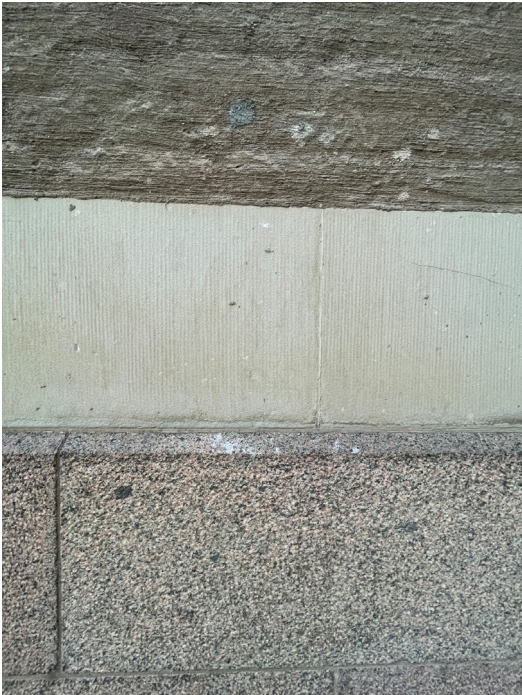
Utsnitt ur fasad med granitsockel, gråslammat tegel och gotländsk sandsten.
