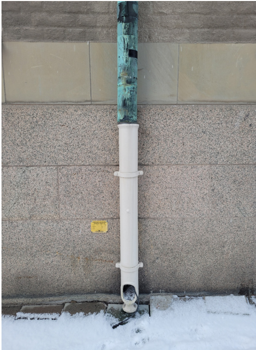
Stuprör, övre delen koppar och nedre delen gjutjärn.
