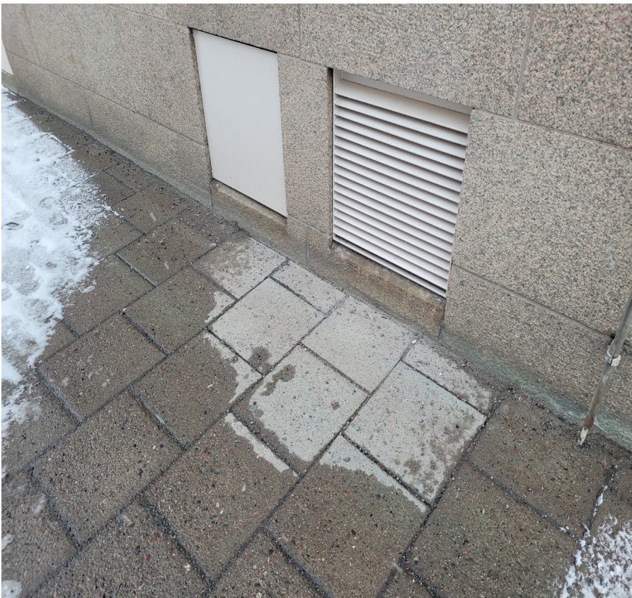
Ventilationsgaller har satts in i öppningar i sockeln. Många källarfönster har täckts för med skivor eftersom behov av ljusinsläpp till övre källaren idag är begränsat.
