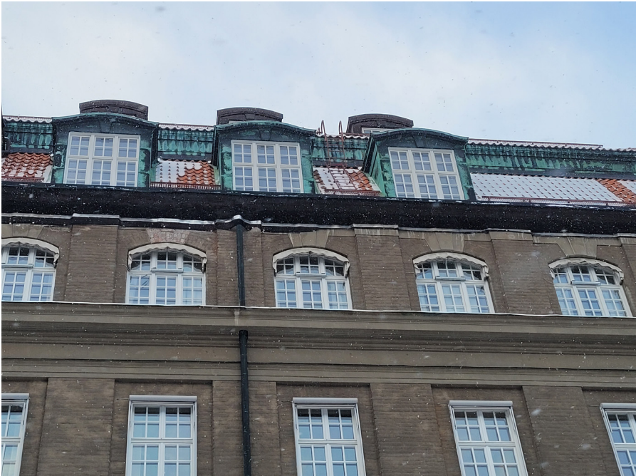
Takkuporna har "slutstenar" i koppar. Slutstenar av sandsten har i något fall tagits ned pga. risk för nedfall.
