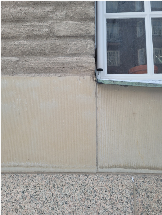
Utsnitt ur fasad med granitsockel, gråslammat tegel och gotländsk sandsten.
