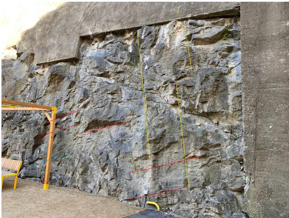
Figur 12: Östra delen av slänten. De röda strecken representerar den F1 som följer foliationen. De gula strecken representerar sprickgrupp 2.
