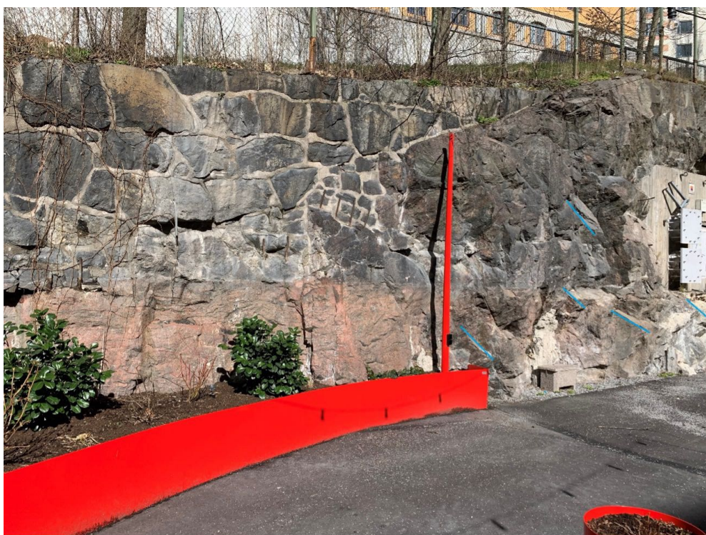
Figur 15: Västra delen av slänten. De blå strecken till höger i bild representerar sprickgrupp 4.
