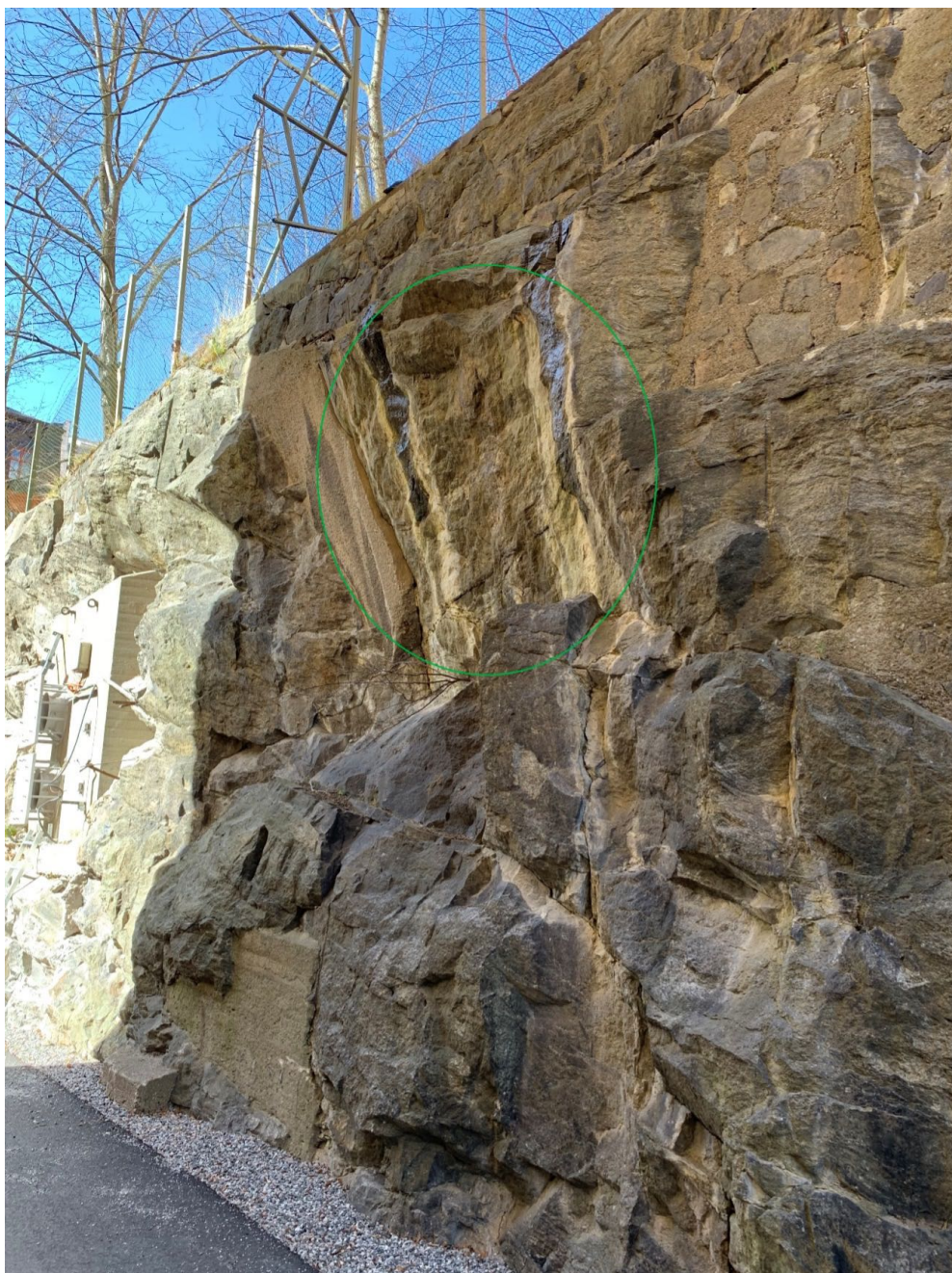
Figur 14: Centrala delen av slänten. Den gröna cirkeln visar sprickgrupp 3.
