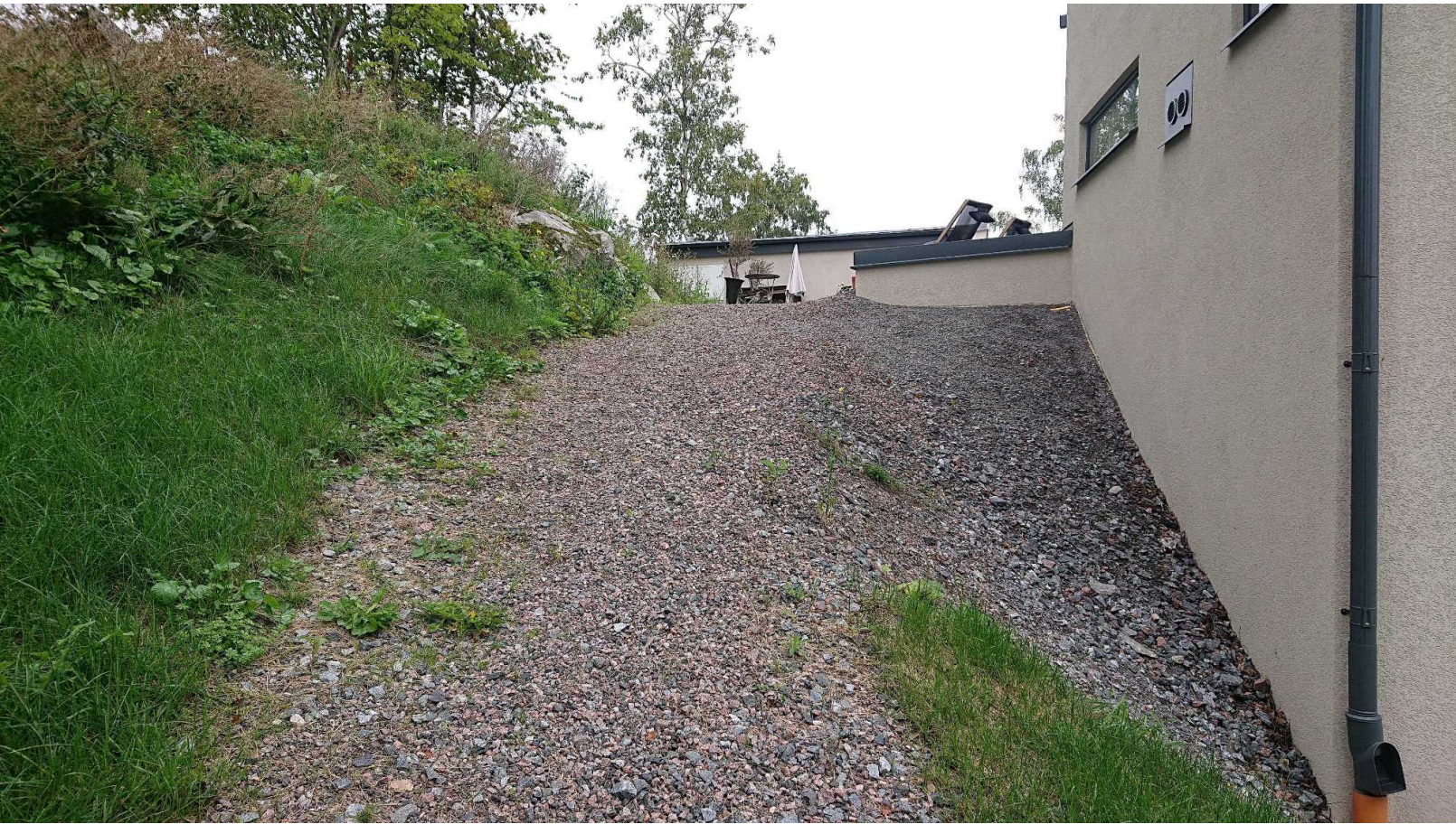
Otillgänglig slänt mot nedre delen av trädgården, dagvattnet leds in mot fasad.
