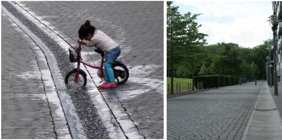
Figur 13. Exempel på rännor i kombination med permeabel beläggning (Bild: Sweco/Tengbom).
