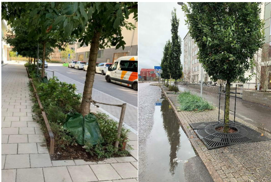
Figur 20. Exempel på skelettjordar med yttlig tillrinning respektive tillrinning via brunn.
