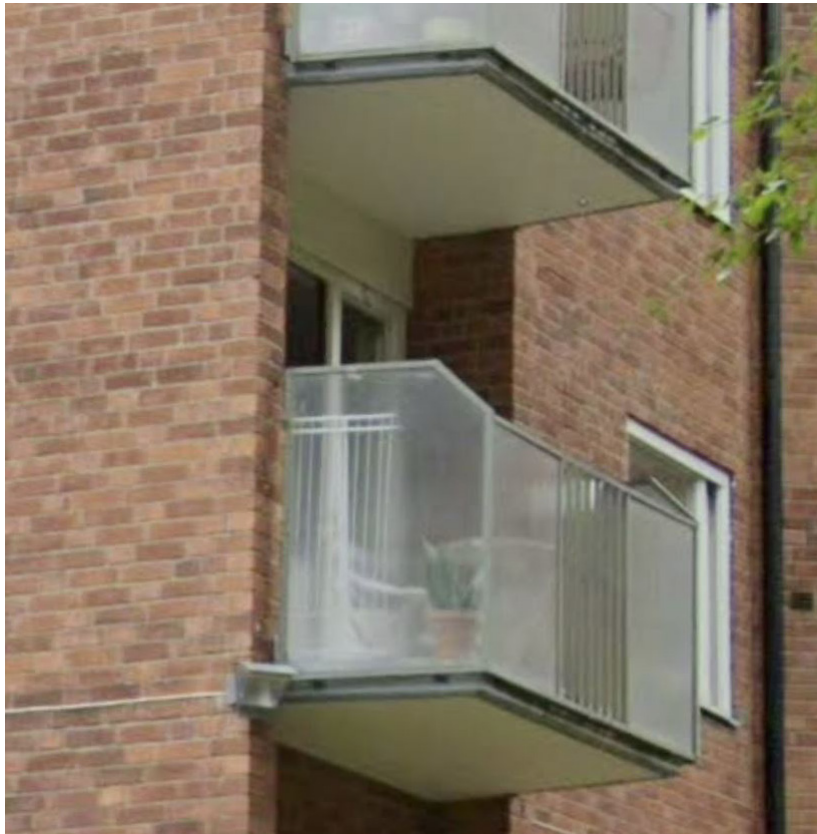
Exempel på balkong med opalt glas kombinerat med smidesräcke, fastighet från 50/60-talet
